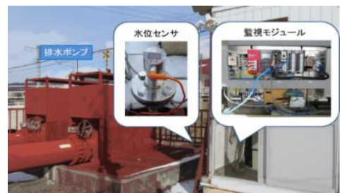
▲内水排水ポンプ監視システムのイメージ
