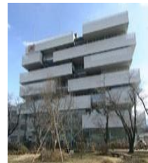
▲日本無線先端技術センター
