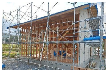
【建築中の状況】
