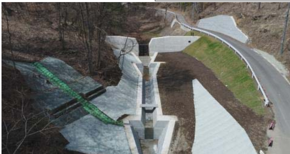
1号砂防堰堤 (H28 年度完成) と 渓流保全工 (H29 年度完成)
