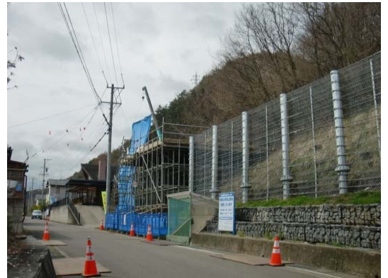
崩壊土砂防止柵施工状況
