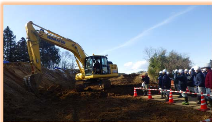
MC バックホウによる掘削状況
