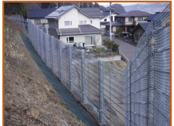
崩壊土砂防止柵施工状況
