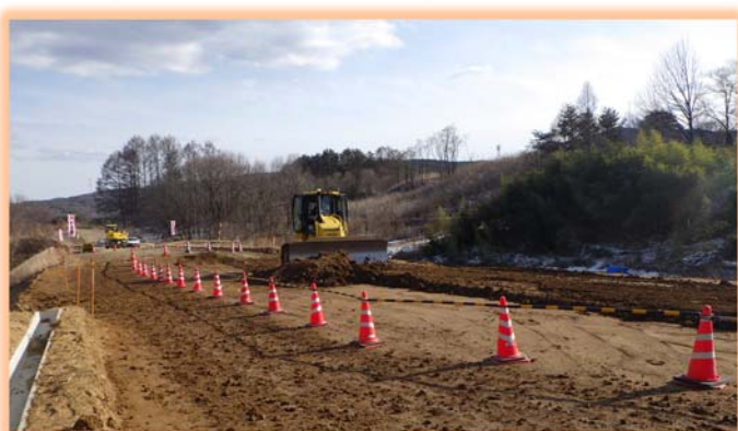
MC ブルドーザによる敷均し状況
