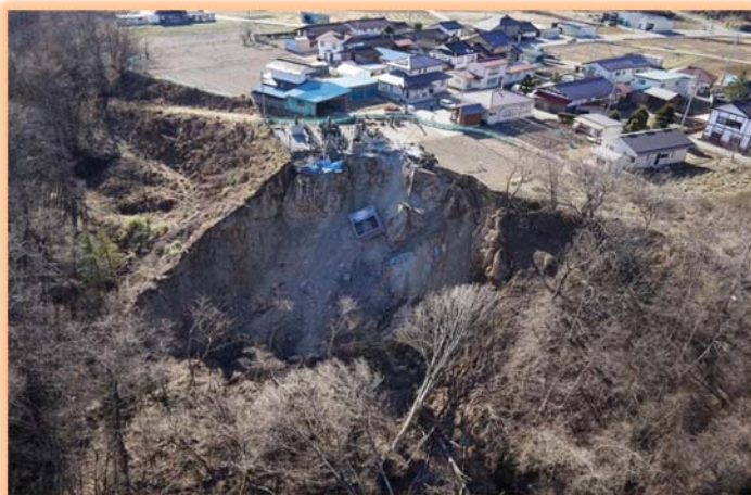
斜面崩壊時の状況 (H27.12.8撮影)
