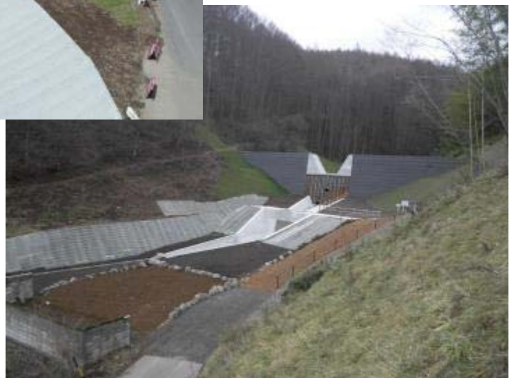
2号砂防堰堤 (H26 年度完成)
