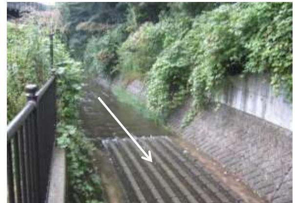
河道の状況 (河床低下の影響を受けないよう護床工を設置)
