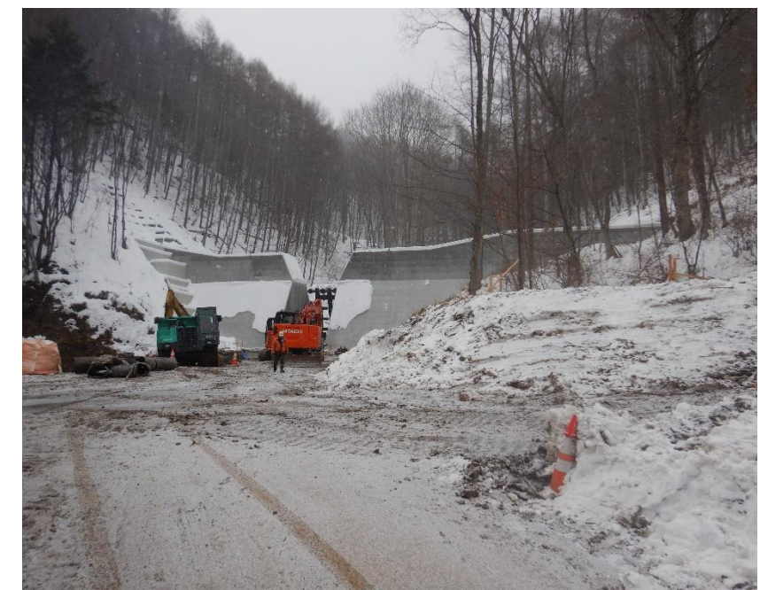
1号堰堤 進捗状況
