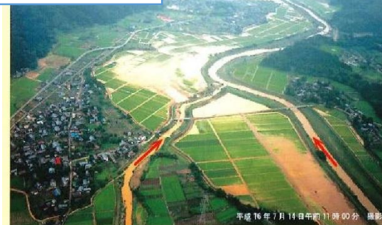
遊水地C・D池付近被災状況
