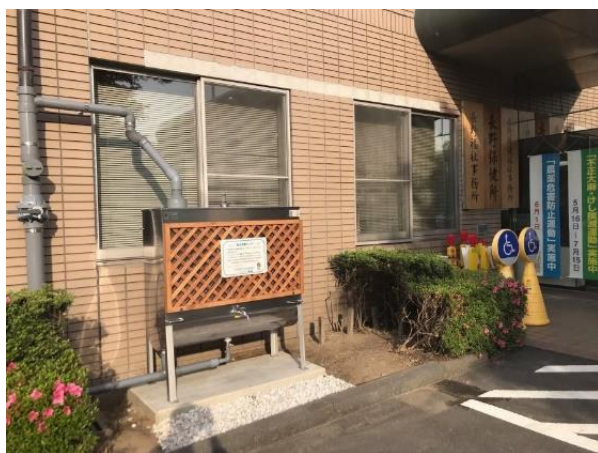
写真-11 雨水貯留タンク設置状況
