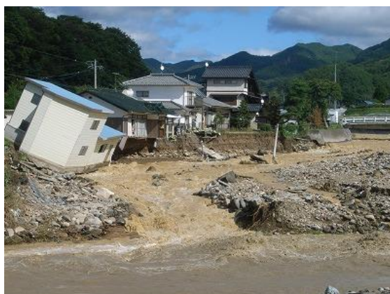
写真-7 抜井川被災状況写真
