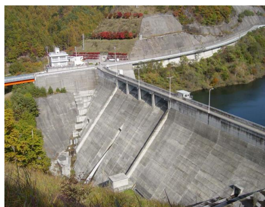
写真-6 古谷ダム
