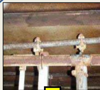
配管周りは雑巾、スポンジを使って洗浄する。
