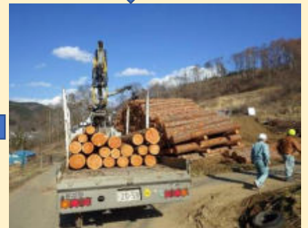
非認証材との混在を避けるため認証材のみを運搬します。
