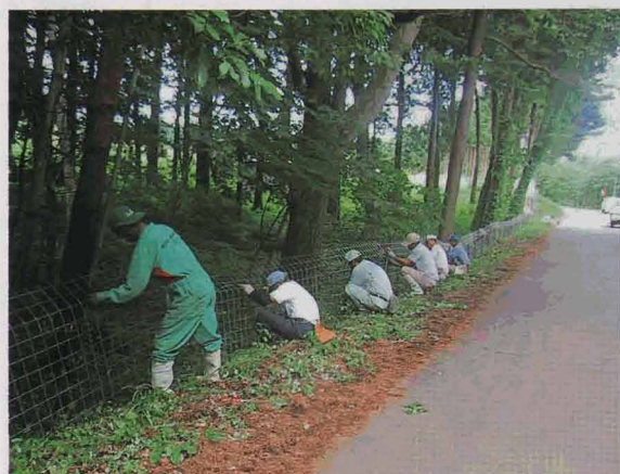
被害を防ぐ為、集落住民みんなで防護柵を設置
