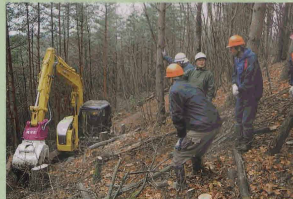
作業路の開設研修の様子
