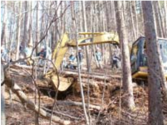
能率的に間伐材を搬出する作業路をあける 実演も行いました。
