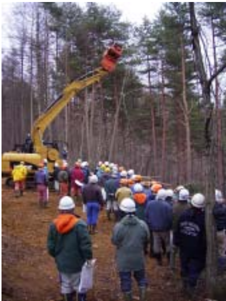
スイングヤーダ…ワイヤーで間伐材を引き出します。
