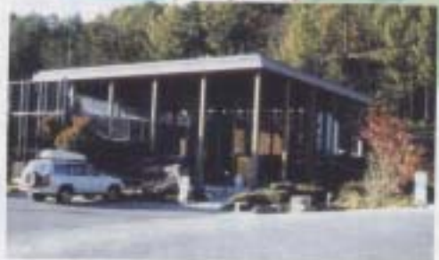
川上村林業総合センター
