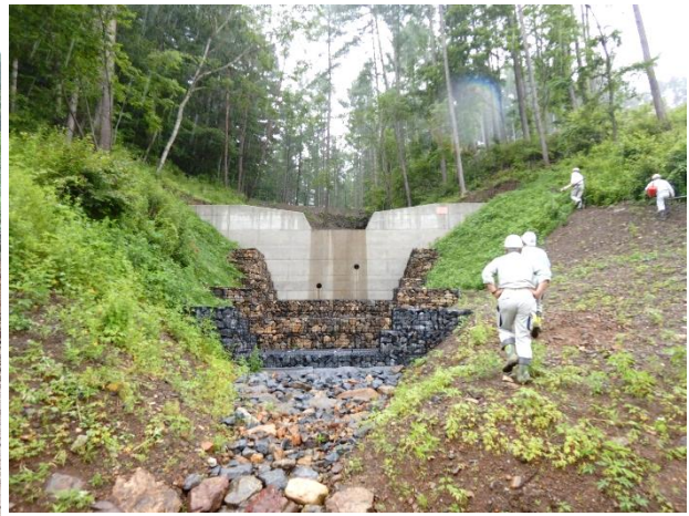
谷止工及 施工状況
