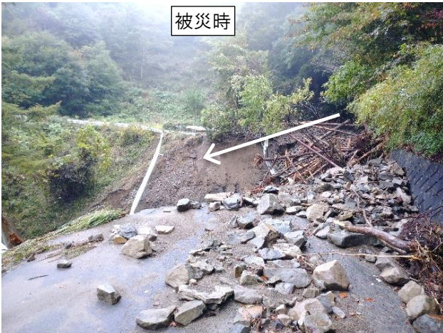
土石流により流失した路体を復旧
