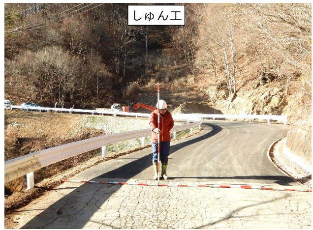
土石流により流失した路体を復旧
