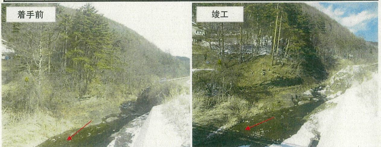
(令和3年度 施工箇所 一級河川千曲川 川上村 梓山 )
