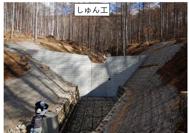
NO3 谷止工及び流路工 施工状況
