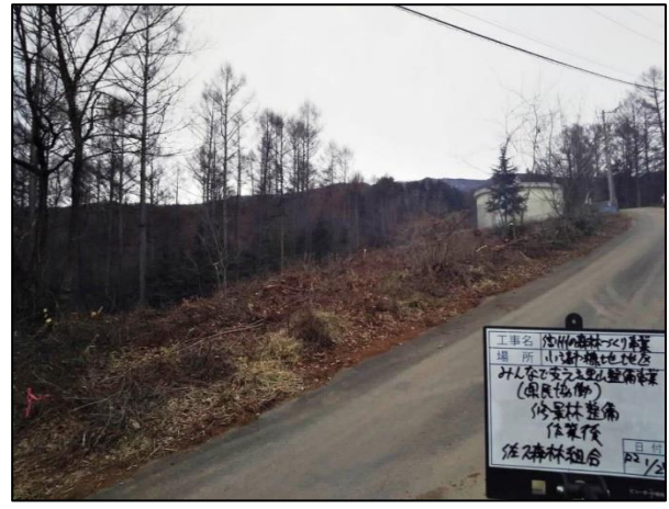
小諸市糠地 修景林整備(施工後)
