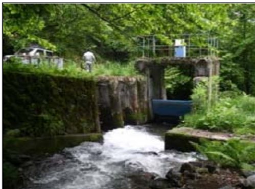
頭首工改修工事（仮） 立科町：立科幹線地区
