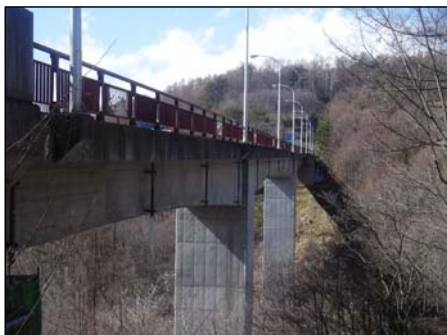
埋沢大橋の耐震補強を実施 川上村：川上地区
