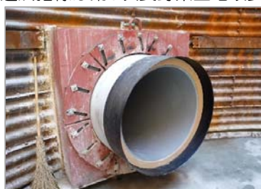
整備した基幹的農業水利施設（水路トンネル） （御代田町：大久保地区）
