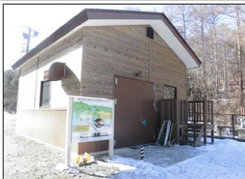
陣内森林公園発電所
