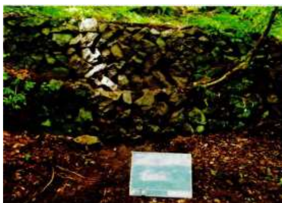
【石積修繕工事 完了】
