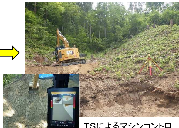
TSによるマシンコントロールで重機オペレーターの掘削を支援
