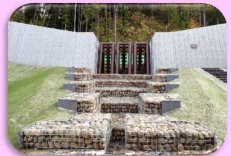
砂防堰堤正面から
