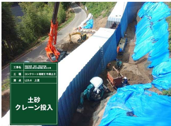
クレーンでの土砂投入
