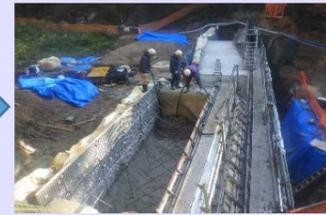
残存型枠の内側にコンクリートを打設します
