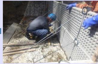
垂直面となる本堤上流側に残存型枠を設置します
