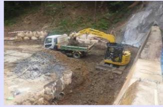
下流側は砂防堰堤の全容がわかるように掘削します
