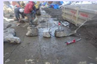
搬入した石にアンカーを取り付けます
