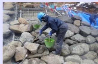
石材および目地部を清掃して完了
