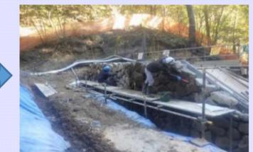
石材および目地部を清掃して垂直面は完了
