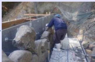
その石を残存型枠に固定します
