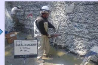
ハツリ面に鉄筋を差します
