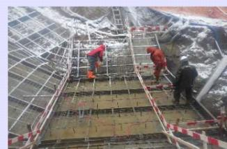
架台の上にメッシュ筋を配置・固定します
