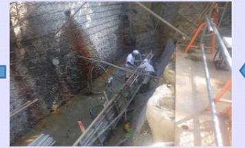
その前面にコンクリートを増し厚するため型枠を設置します
