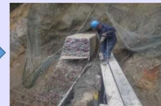
残存型枠と石材との間にもコンクリートを打設します
