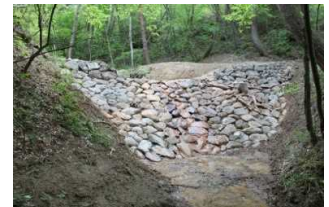
国の登録有形文化財 芦澤第三号石積堰堤
