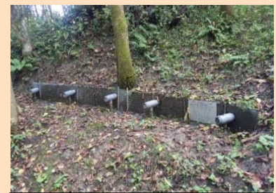
横ボーリング工による地下水排除
