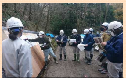
伊藤講師による工事現場説明
