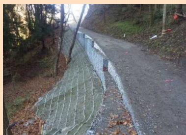
土留工による村道復旧
