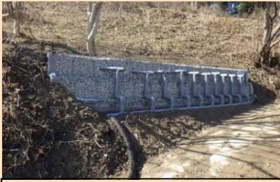
横ボーリング工による地下水排除
