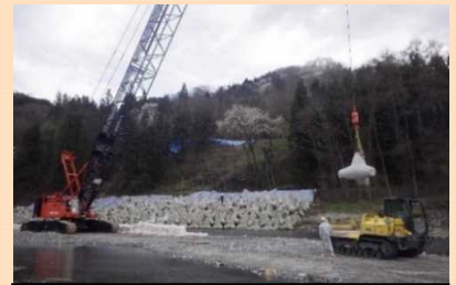
根固ブロックによる押え盛土
