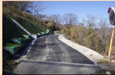
カゴ枠工によるのり面安定化
