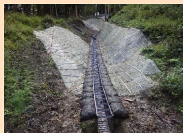
水路工による地下水排除
