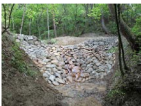
＜芦澤 第三号石積堰堤＞
