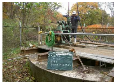
排水ボーリング再掘削状況 (平成23年撮影)
