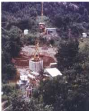
集水井筒(1号 ケーソン) (昭和44年撮影)
