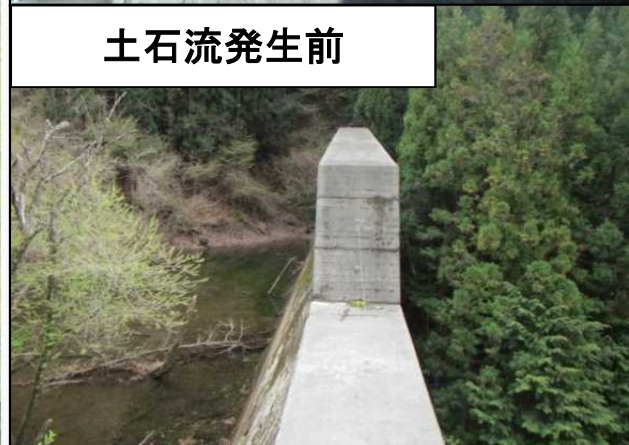
梨子沢砂防堰堤 S46完成 H=20.0m L=123.7m
