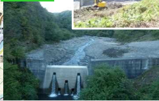
倉本砂防堰堤
