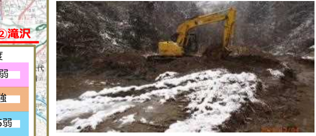
⑧ 白沢 白馬村 神城 【砂防】既設砂防堰堤の除石工事 白沢砂防堰堤 (5) (H26 12/2~11)
