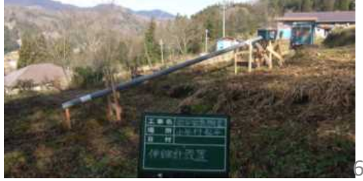
⑳ 梨沢 小谷村 千国 【地すべり】伸縮計観測による監視 (H26 11/27~)
