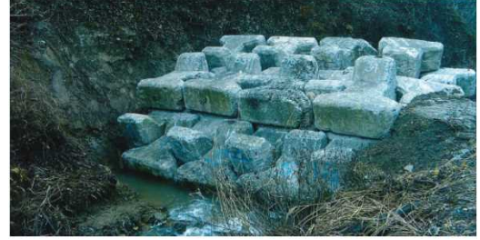
⑱ 黒木沢 小谷村 中土 【地すべり】異形ブロックによる仮設堰堤設置 (H26 12/5完了)
