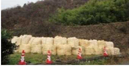
⑩ 新諏訪町 長野市 西長野 【急傾斜】人家裏に大型土のう設置 (長野市)
