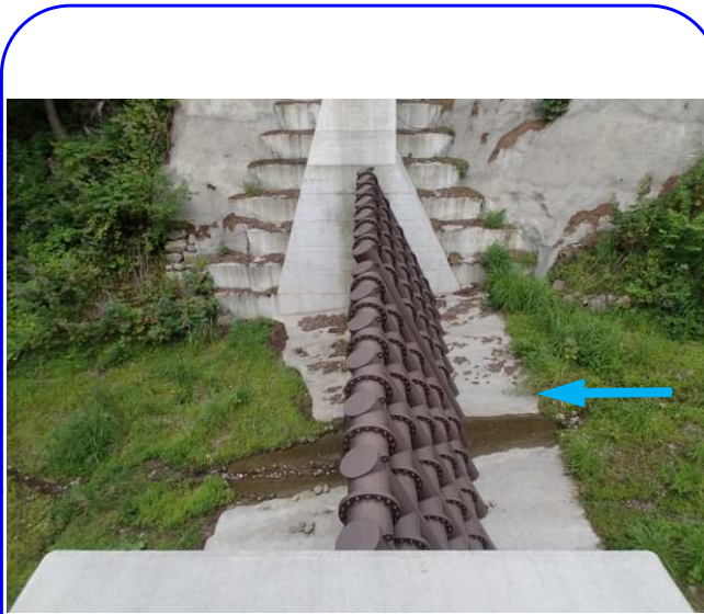
土石流発生前 (H25.8.26撮影)
