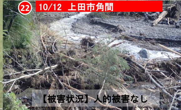
【被害状況】人的被害なし
