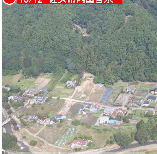
【被害状況】人的被害なし
