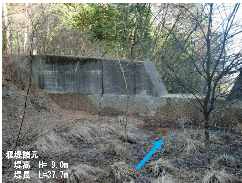
土石流発生前 (H31.3.20撮影)
