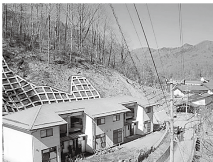
湯沢地区 完成写真
