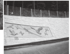
完成写真(左)ともたれ擁壁工(右)
