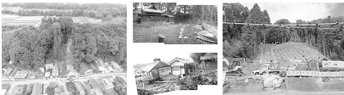
天神地区 被災写真(左)と施工写真(右)
