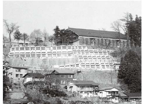
水の手地区 完成写真
