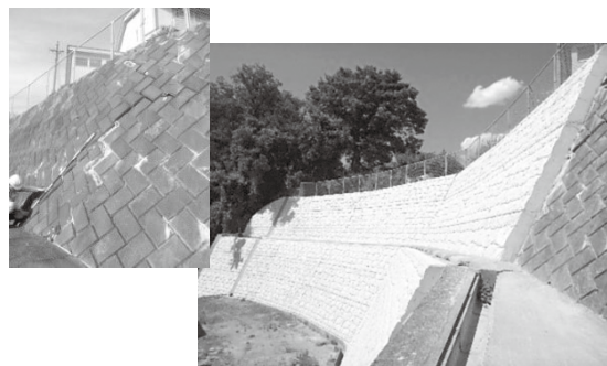
天神町地区 補強前(左)と補強後(右)
