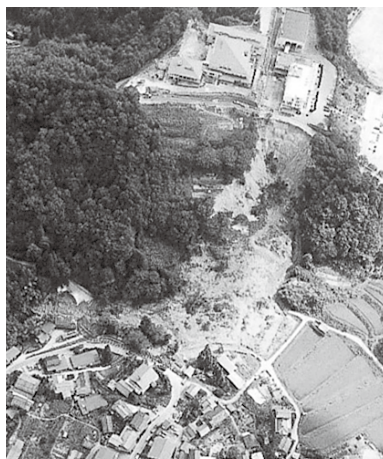
井戸地すべり被害状況
