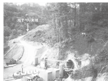
同左、施工中の2号排水トンネル工 (平成10年)
