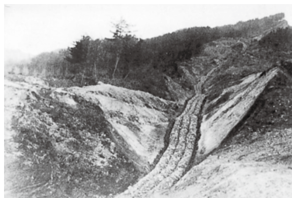
同上、蛇籠水路施工状況
