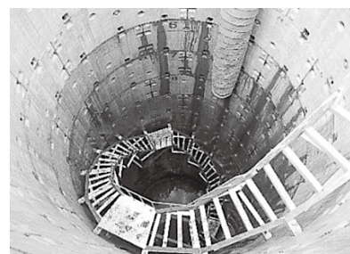
同左、完成した集水井
