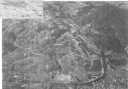
同左、対策後の地すべり全景（昭和60年）
