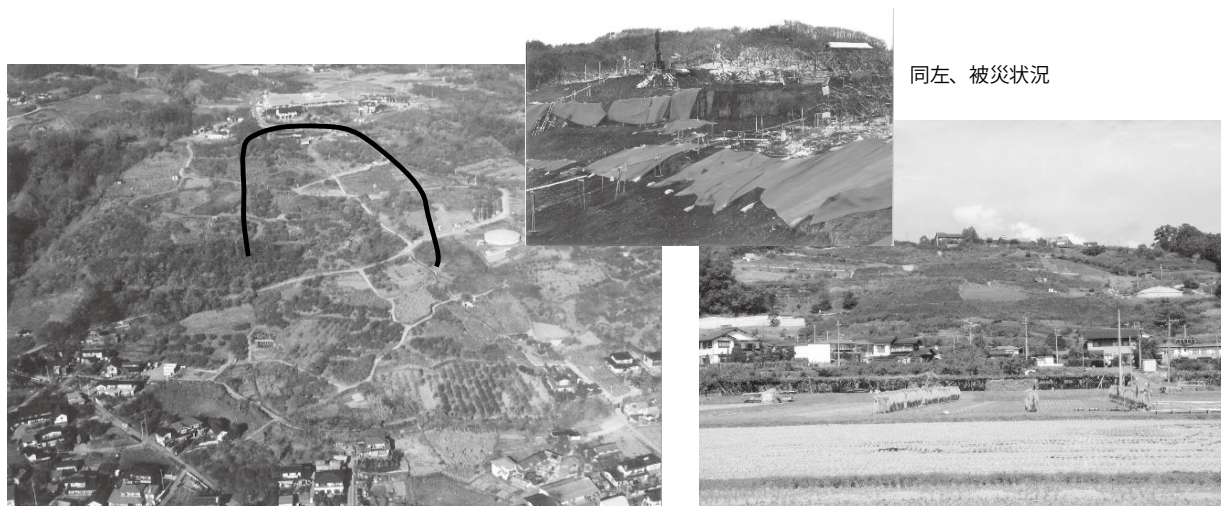
下石川地すべり全景
