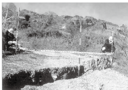
同左、発生した段差
