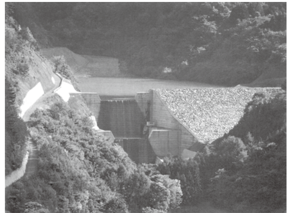
月沢砂防ダム（松本市）
