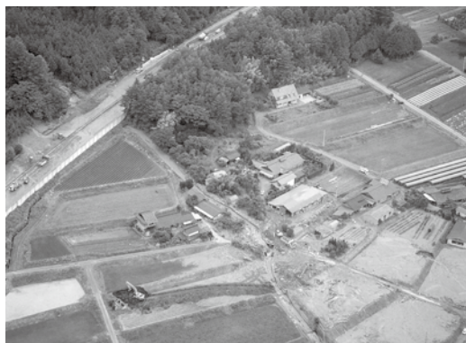
前沢川 土石流による被災状況 (H18.7) (伊那市)
