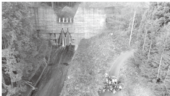
前沢川砂防堰堤
