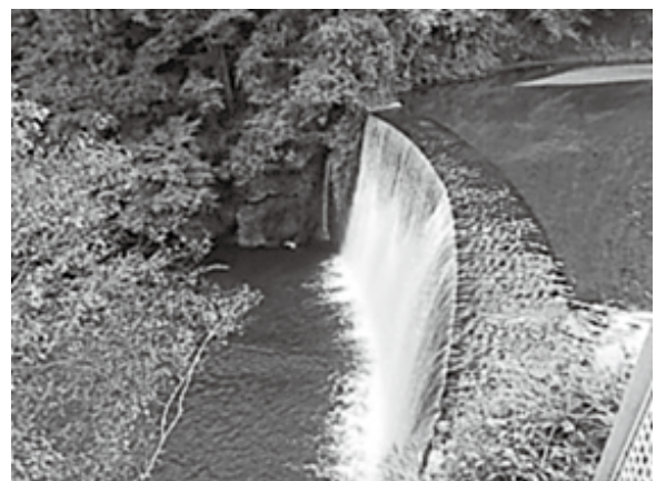
坪根堰堤（長野市）
