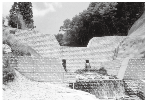
井戸入沢1号砂防堰堤(根羽村)
