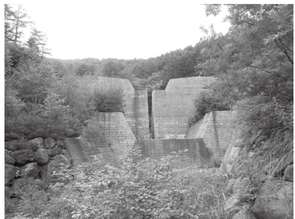
茨沢砂防ダム（小海町）
