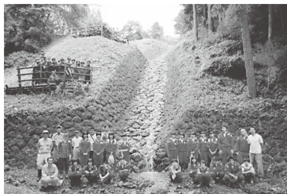
薬師沢石張水路工（写真は富吉沢）（小川村）
