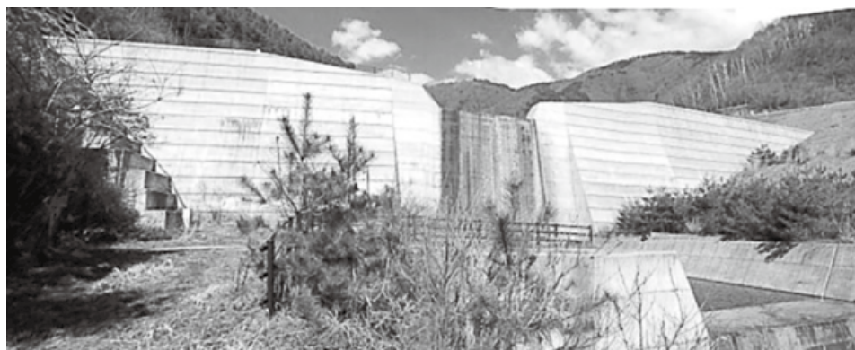
氷室砂防ダム（筑北村）
