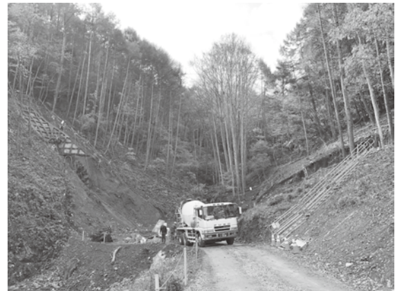
R1災関箇所施工状況 漆入沢 (佐久穂町)
