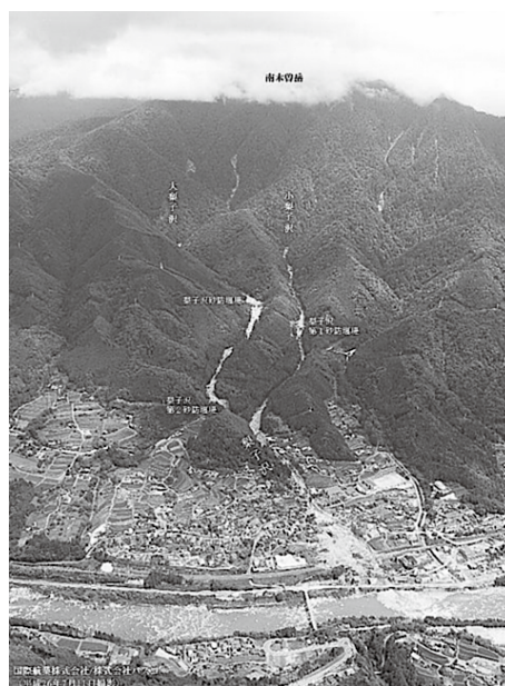
梨子沢土石流災害（南木曾町）
