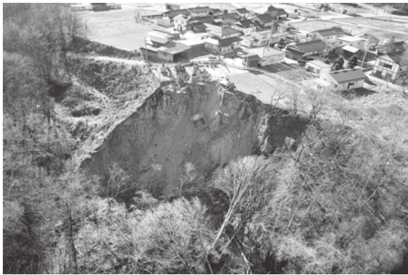
大月川崩落 (小海町)
