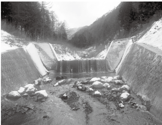
平沢床固工 (伊那市)
