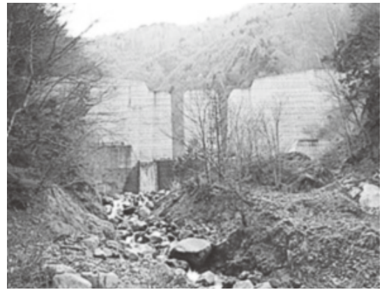
桂小場砂防堰堤 (伊那市)
