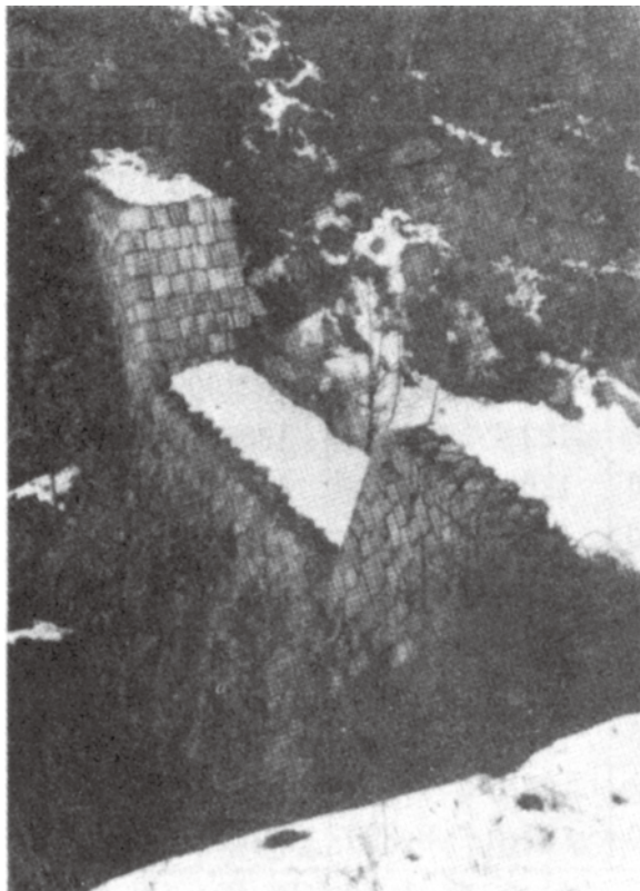
昭和16年施工の秋山砂防ダム（川上村）
