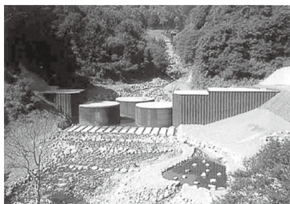
土沢川（完成）（小谷村）
