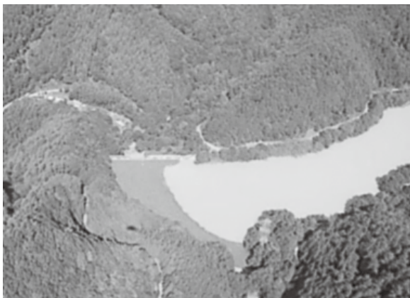
雨川砂防ダム (佐久市)
