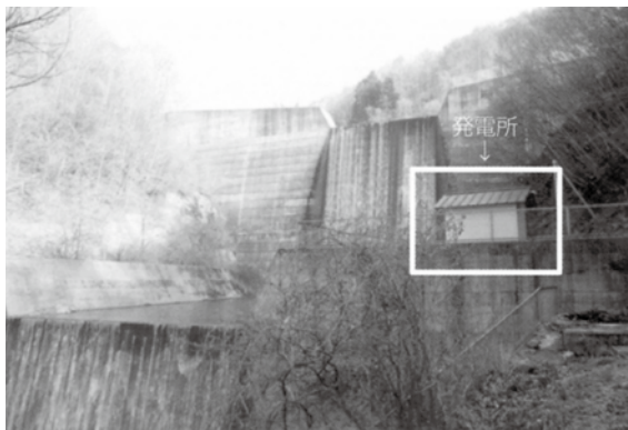
大岡浅刈小水力発電所（長野市）
