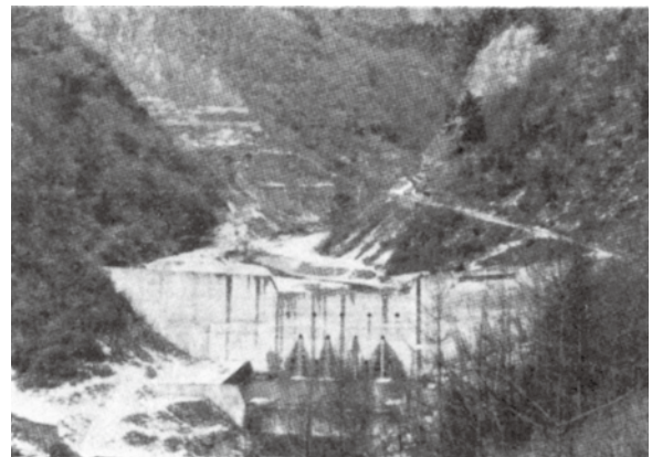
横河山砂防ダム（岡谷市）
