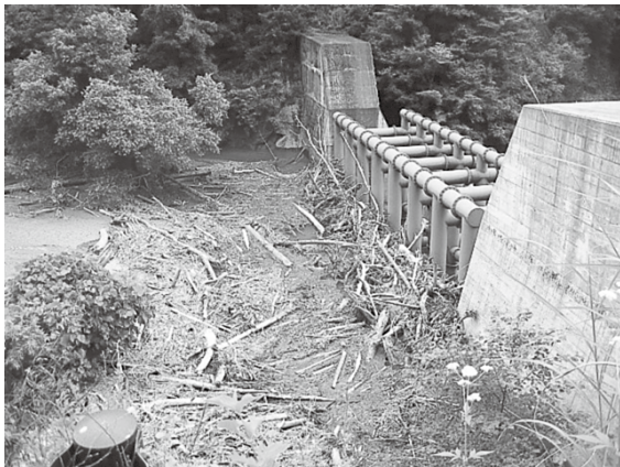
楠川（長野市）楠川砂防ダム（2000C型） 土石流捕捉状況（平成21年8月）
