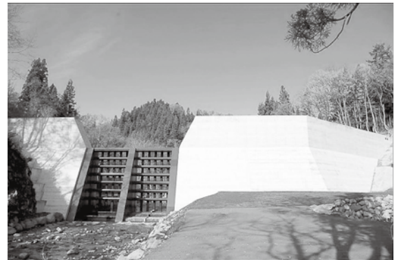
井出川（飯山市）出川照岡砂防堰堤（CBBO型）
