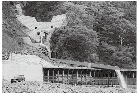
工事中の小谷村常蔵沢(砂防激特)
