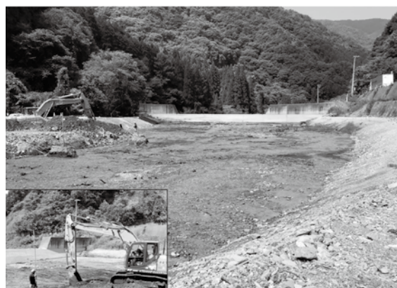
仙仁川（須坂市）仙仁砂防堰堤 ICTによる除石状況
