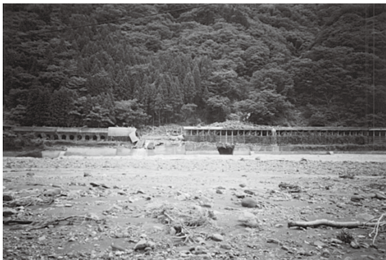
被災後の小谷村常蔵沢
