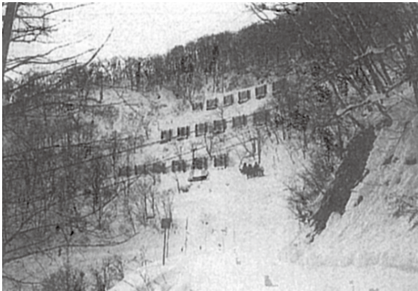
みそら野地区雪崩予防柵
