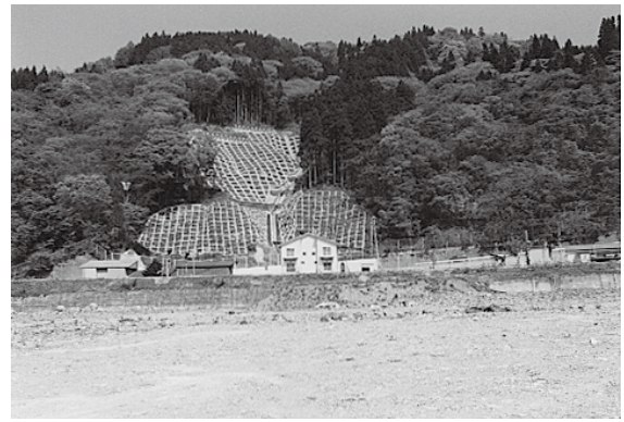
復旧した北小谷駅(災関急傾 小谷村 光明)
