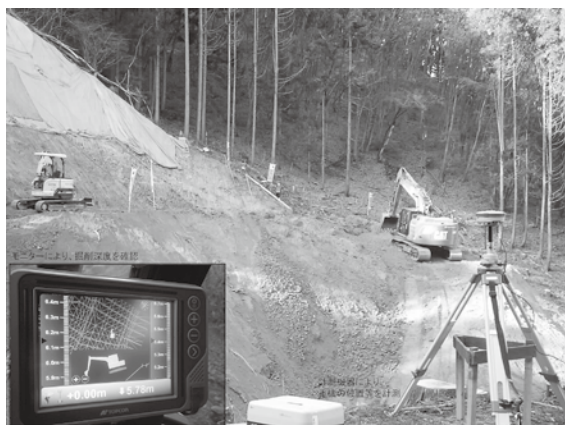
樽沢川（高山村）1号堰堤 ICT土工施工状況
