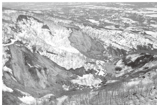
栄村中条川 崩壊地
