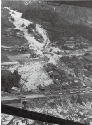
土石流が流出した大沢田川（南木曽町）の惨状
