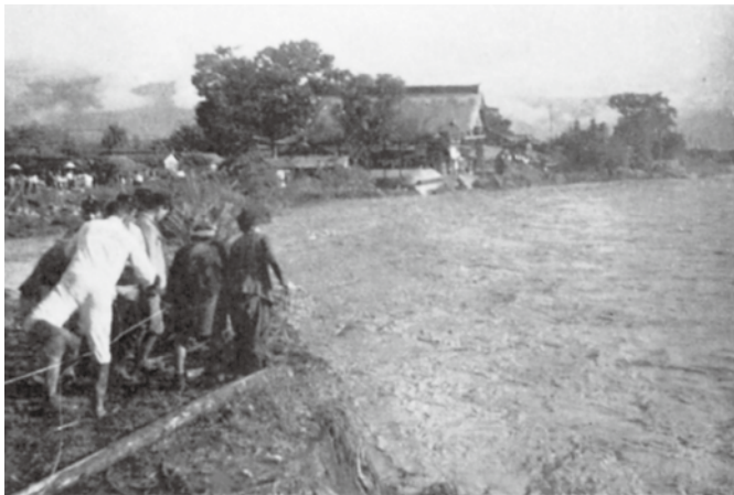
昭和24年9月23日の裾花川災害による堤防決壊状況
