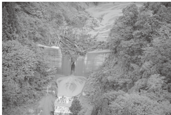
井出川 桑名川砂防堰堤 大量の土砂・流木を捕捉
