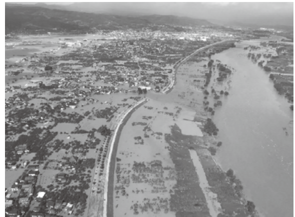
図4 長野市穂保地区での千曲川堤防決壊
