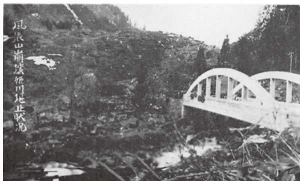
北安曇郡小谷村親沢 風張山の崩壊により姫川がせき止められる崩壊地を下流から望む 手前の小溪流は西親沢(崩壊直後撮影)
