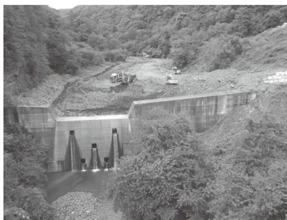
湯川 倉本砂防堰堤除去
