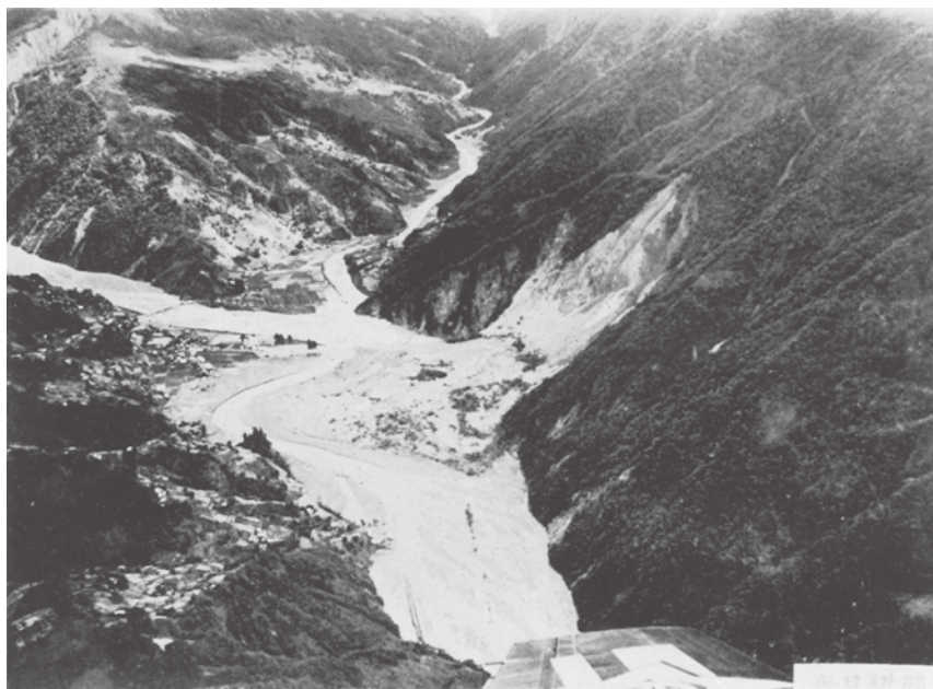
昭和36年6月大西山（下伊那郡大鹿村大河原）崩壊状況 中央構造線の破碎帯に起こったもので、崩壊土量320万 \text{m}^3
