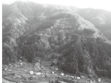
小谷村 カクレ沢 地すべり土塊を捕捉
