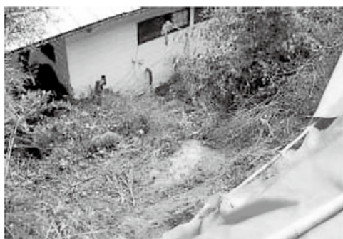
長野市信州新町 斜面が崩壊し人家を襲う
