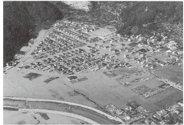
長野市松代温泉団地たん水状況
