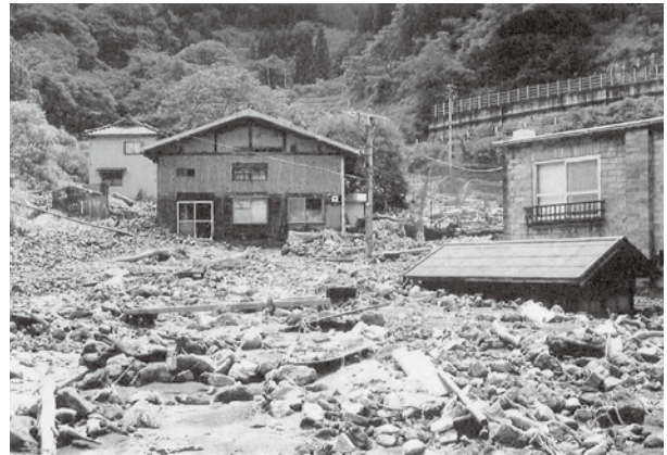
土石流により家屋埋没
