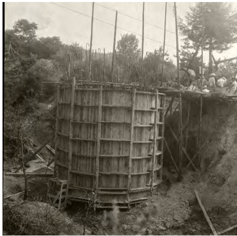
コンクリート打設
