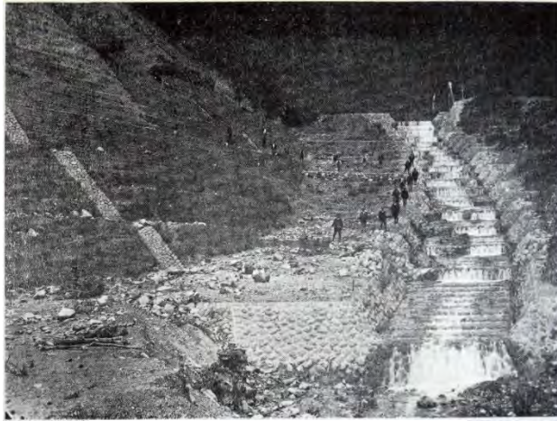
完成した階段工 (撮影年不明) (出典：牛伏川砂防沿革史)
