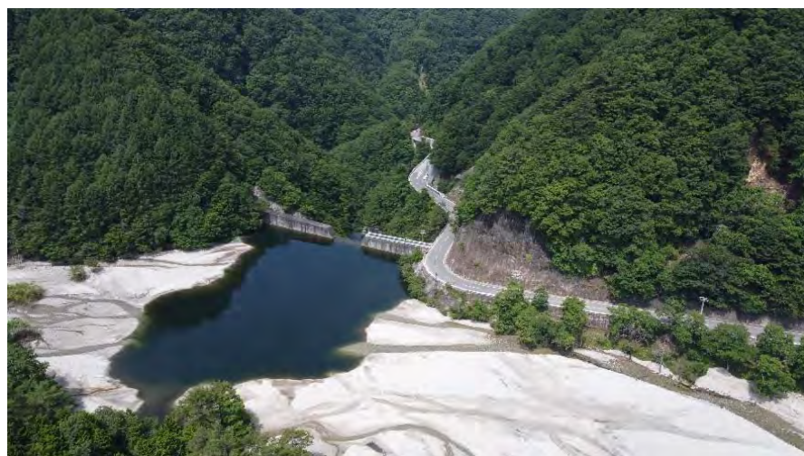
堰堤高 33m 堤長 110m 堤体積 46,846m 3 重力式砂防堰堤 (緯度 35° 26′ 58.6″ 経度 137° 56′ 0.9″ )
