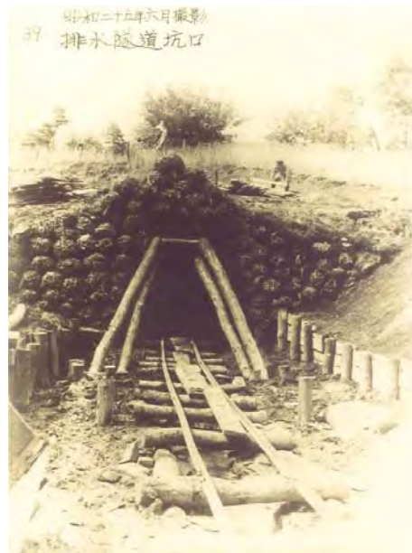
排水トンネル（昭和 25 年）
