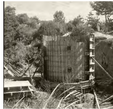
筒外型枠設置
