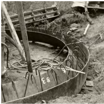
沓の据え付け
