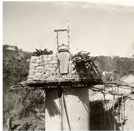
加重による沈下
