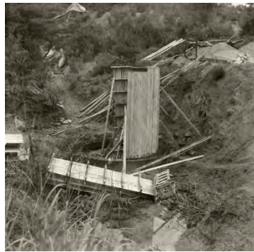
筒内型枠設置
