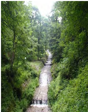
完成した階段工 (撮影年不明) (出典：牛伏川砂防沿革史)
