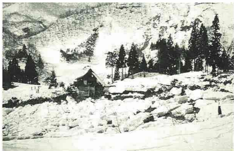
融雪時期地すべり状況
