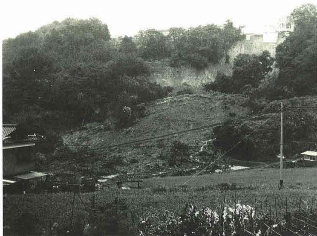
被災直後 平成元年9月
