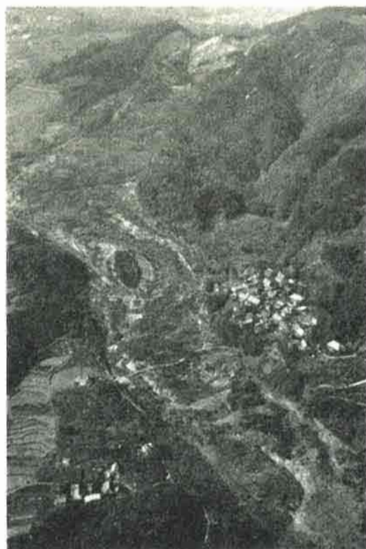
茶臼山地すべり地中間部より上部の状況 向かって右の部落は山新田部落
