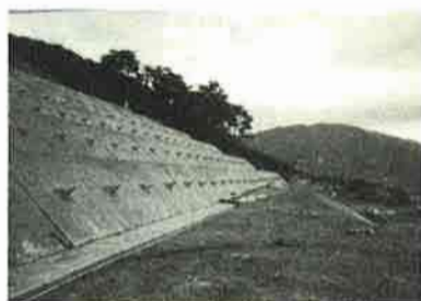
下部アンカー工
