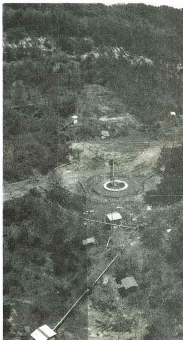
茶臼山地すべり地上部 上沼周辺の排水工群 昭和45年撮影
