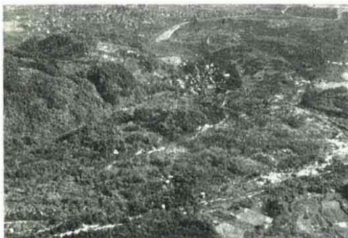
茶臼山地すべり、地すべり発生地帯 下部から下流の状況 写真の上方へ滑落
