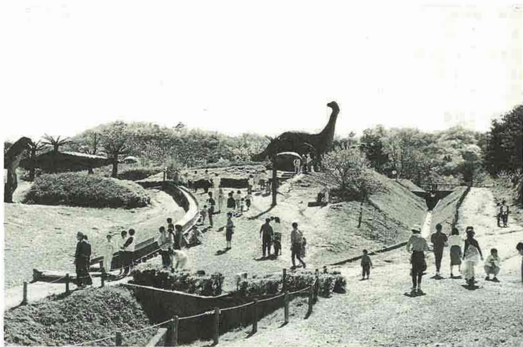
地すべり対策水路と恐竜公園
