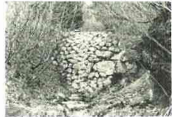
明治末期直轄により施工された谷川砂防ダム
