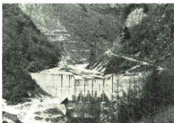
横河山砂防ダム(天竜川支横河川、岡谷市長地)
