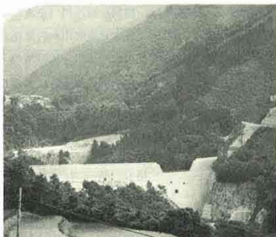
高井砂防ダム
