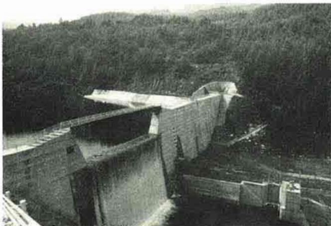
須砂渡砂防ダム(犀川支穂高川支鳥川、南安曇郡堀金村)
