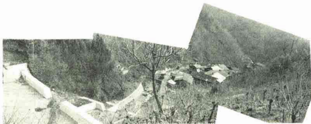
面沢砂防ダム（木曾川支神谷川小支面沢……木曾郡日義村）
