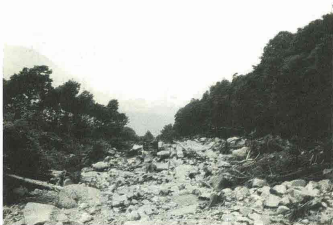
白沢川上流部被災状況
