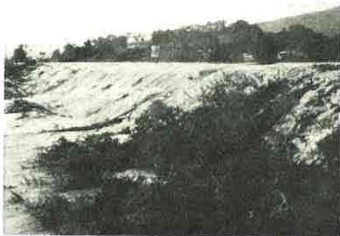
千曲川の背水により溢水中の樽川堤防
