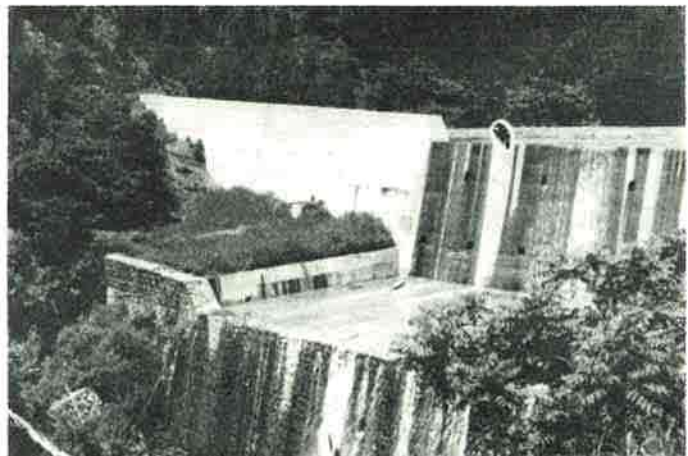
耳尾沢砂防ダム（姫川支中谷川小支耳尾沢……北安曇郡小谷村）
