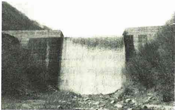
千曲川支依田川小支武石川竜ヶ沢 砂防ダム工 長87.0m 高22.5m (S34~37年度)
