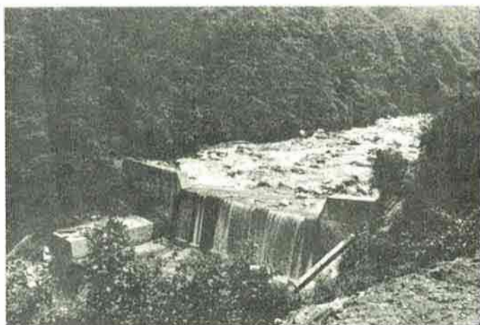
上山沢砂防ダム（木曾川支与川小支上山沢川……木曾郡南木曾町）
