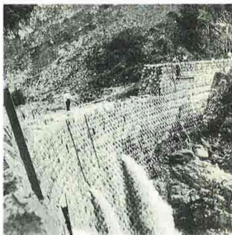
昭和28年再開された箱継砂防ダム
