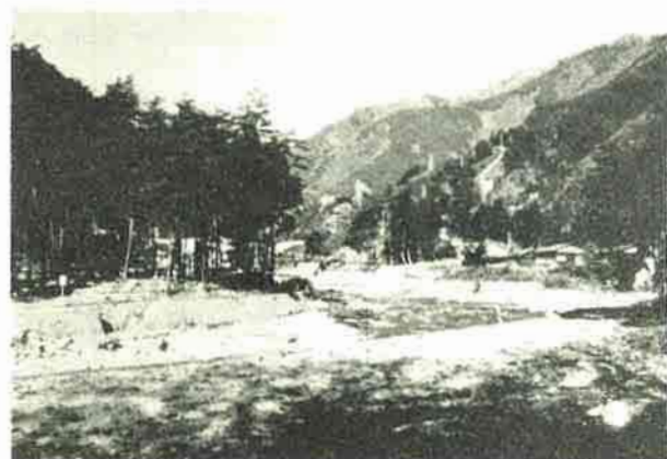
(飯田) 松川流路工 (天竜川支松川……飯田市)
