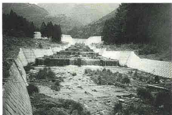
宇原川流路工・曲屋島砂防ダム
