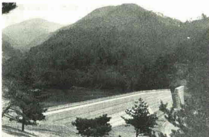
永井砂防ダム(犀川支麻績川小支永井川)
