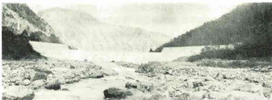
姫川支松川小支南股川の 南股第1号砂防ダム（直轄S37～44年度） H=15m L=115m 貯砂量 6,200 m 工事費 269,077千円
