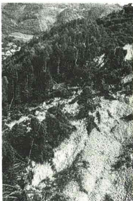
西平山地すべりの状況 (昭和41年10月撮影)
