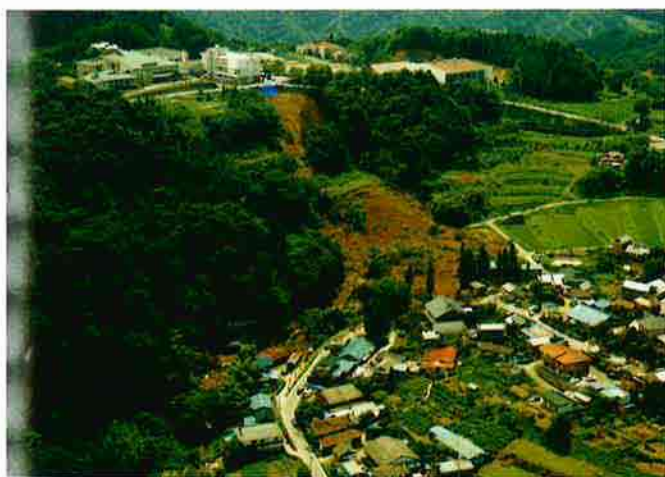
▲被災直後の地すべり地全景 平平成元年9月3日撮影
