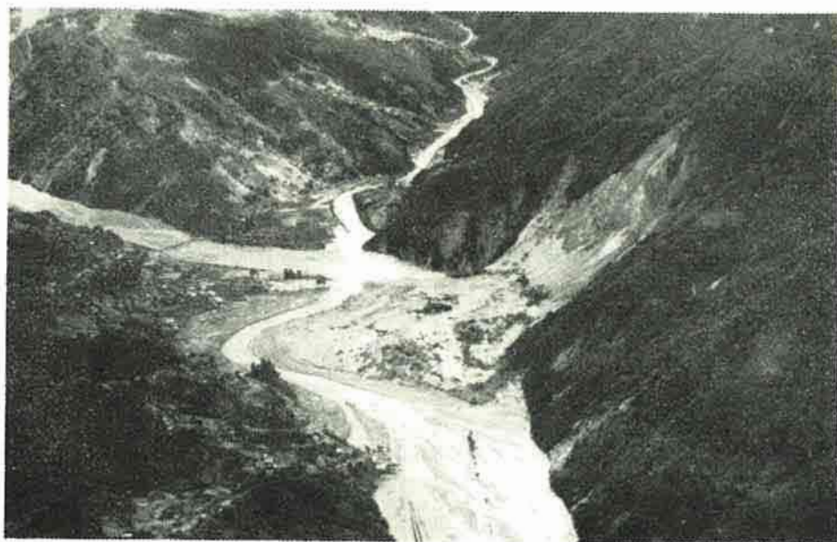
大西山（下伊那郡大鹿村大河原）崩壊状況 中央構造線の破砕帯に起ったもので、崩壊土量320万m 3 に及んだ。
