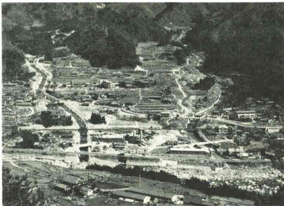
災害復旧事業により整備された大沢田川（右）、梨子沢の流路工
