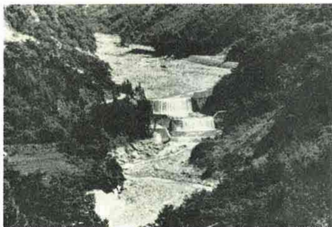
天竜川支小洪川の 釜沢砂防ダム（直轄S12～16年度） H=10m L=53m 貯砂量 59.080 m
