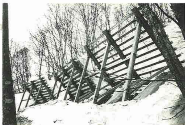
雪崩予防柵設置状況
