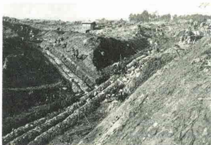
戦前の地すべり対策工事 昭和7年茶臼山地すべり地における 排水工（蛇籠水路工）施工中の状況
