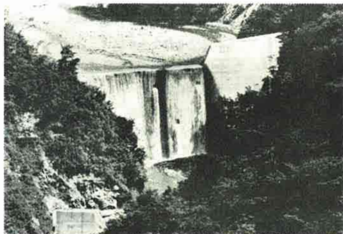
天竜川支小渋川の釜沢第3砂防ダム（直轄S41～43年度）
