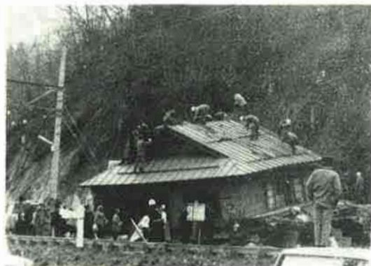
北安曇郡小谷村月岡地籍におけるがけくずれの状況 （S45.4.21発生）
