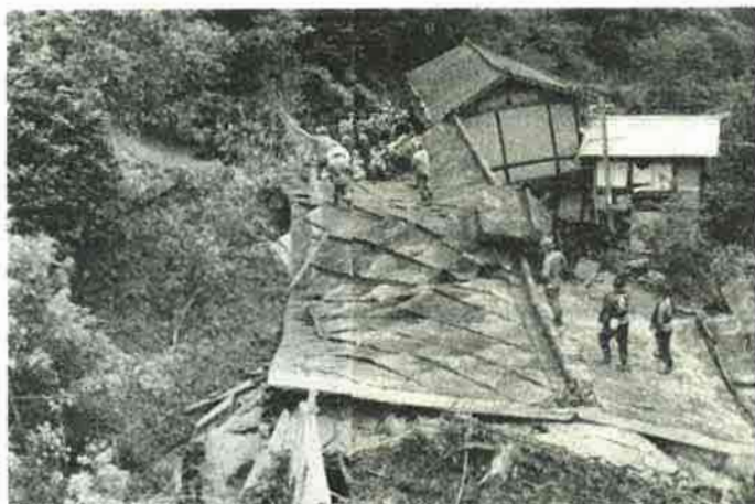
更級郡大岡村和平地籍におけるがけくずれの状況 (S45. 6. 20発生)
