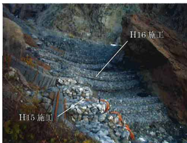
写真 5-4 フトン籠の中詰め石の状況
