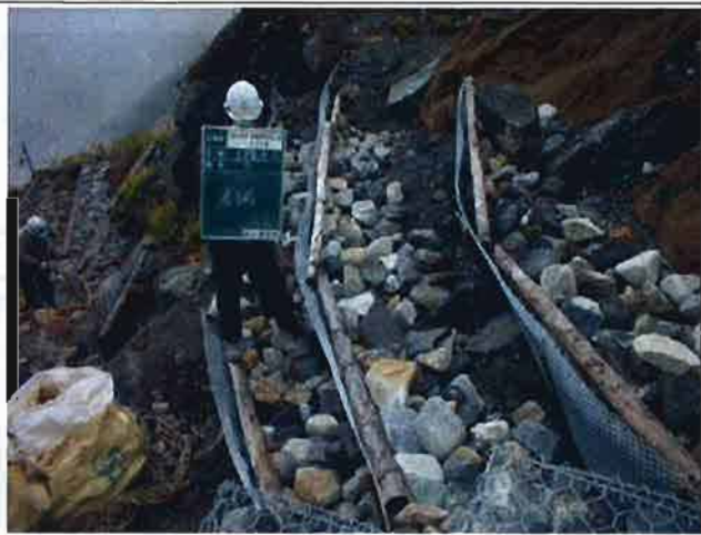
山腹工 H15 施工箇所補修前
