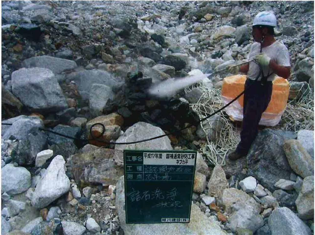
写真 5-2 詰石洗浄状況
