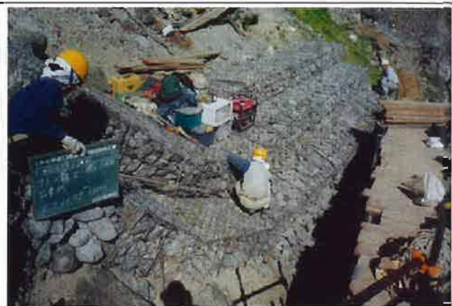
フトン籠設置 横工
