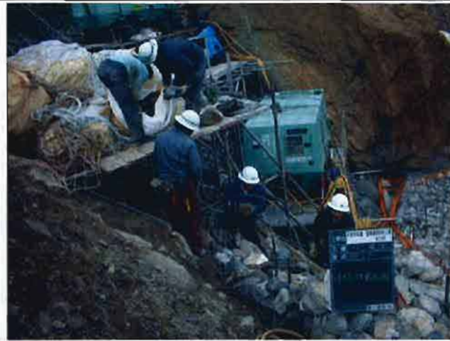
フトン管工 詰石工施工状況
