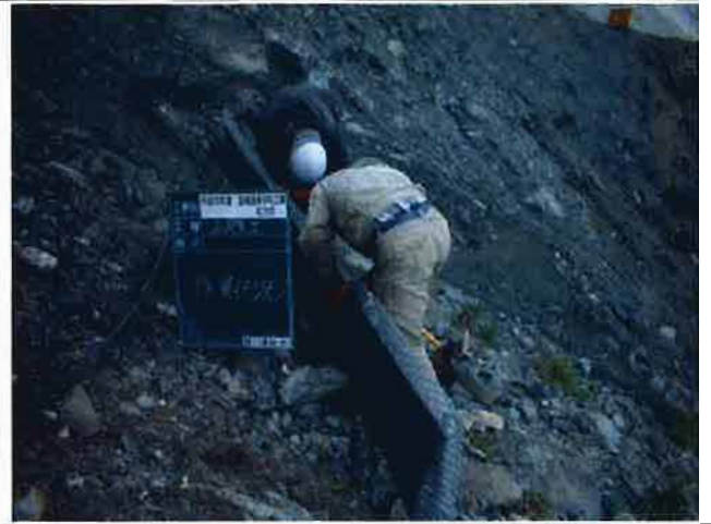
山腹工 壁面材設置工
