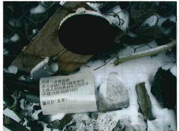
凍結防止のためスポンジゴムにて保護
