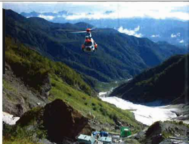
運搬工 詰石搬入
