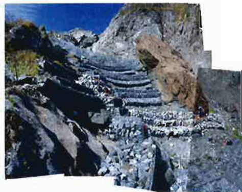
平成 17 年度調査時の状況 (第 3 期施工後にアンケートを実施) 構造物：横工 5 基＋縦工 9 基＋ 鋼製柵工＋金網張工＋植生ネット工
