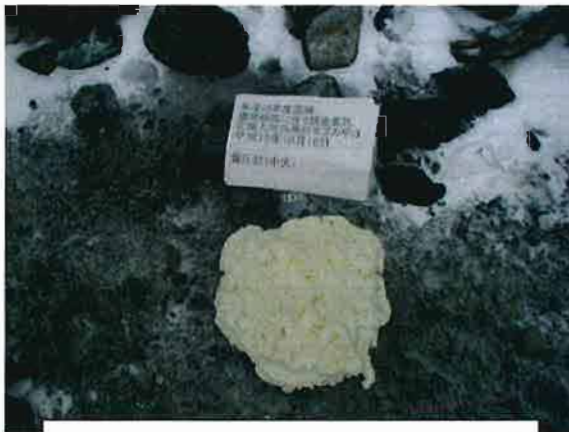
凍結防止のためスポンジゴム、発泡ウレタンにて保護
