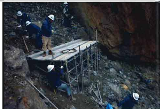
仮設工 コンプレッサー足場
