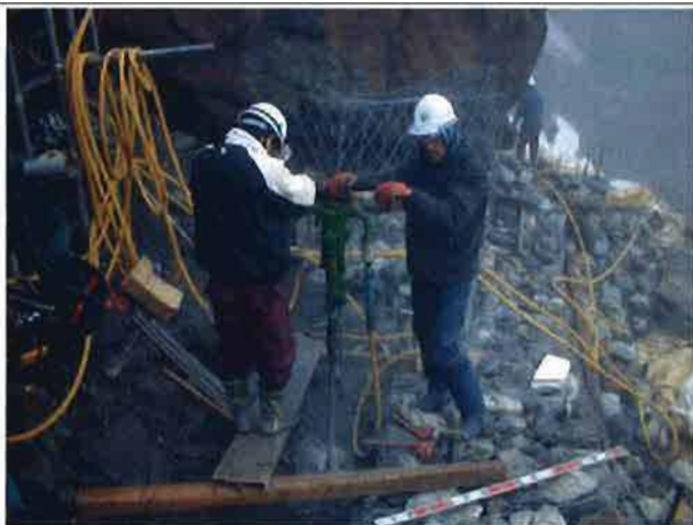
フトン籠工 削孔工施工状況
