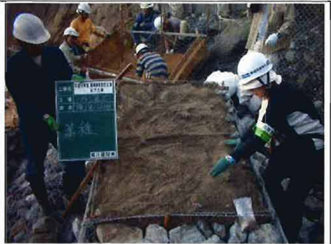
フトン管工 焼砂充填による植生基盤工(3)
