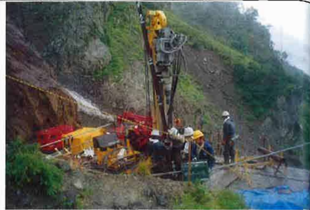
H網建込 施工状況
