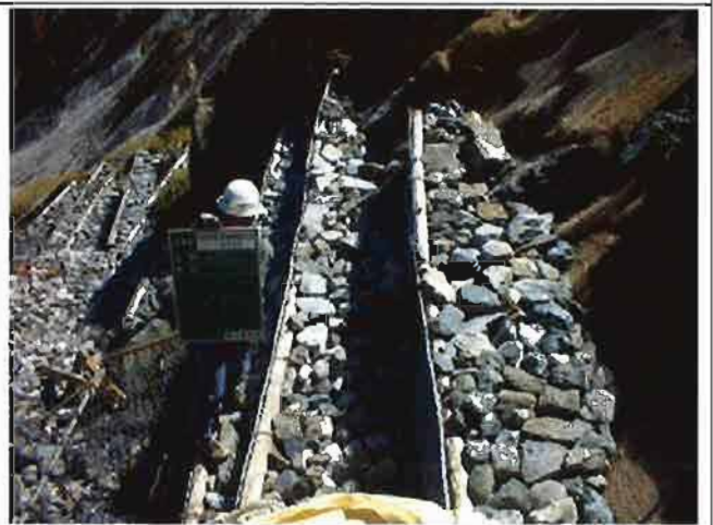
山腹工 補修後
