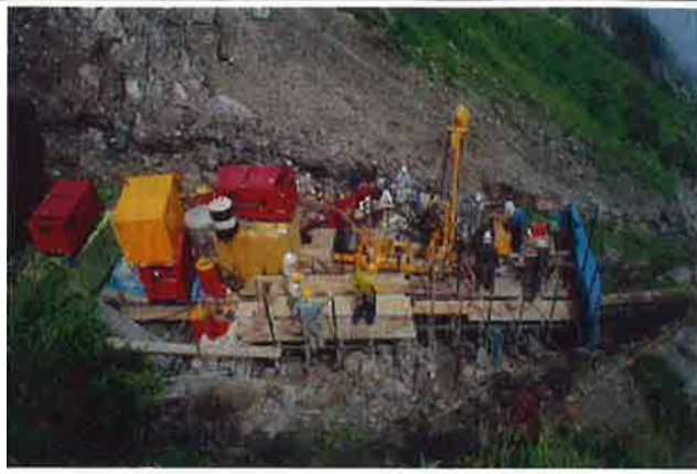
ボーリング工 施工状況
