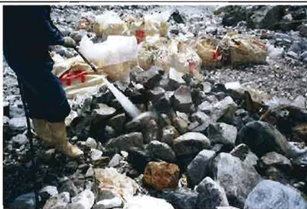
詰石採取 洗浄状況
