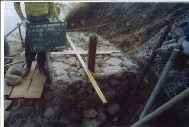
フトン籠設置 縦工 No. 1 2 段目
