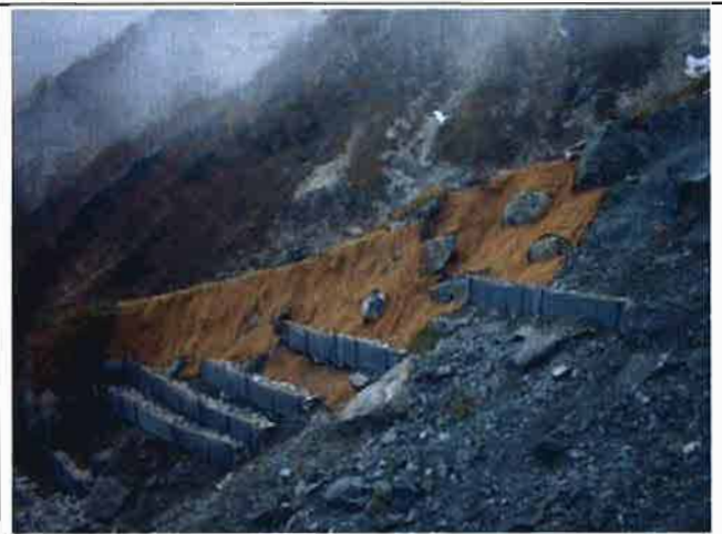
のり面保護工 繊維ネット網
