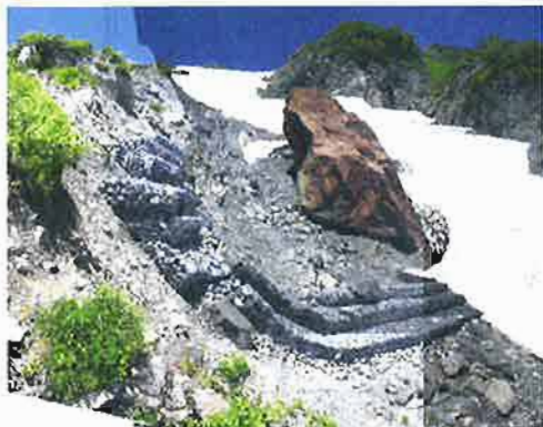
平成 14 年度調査時の状況 (第 1 期施工後にアンケートを実施) 構造物：横工 1 基＋縦工 3 基のみ
