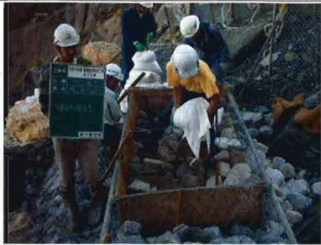
フトン管工 焼砂充填による植生基盤工(2)
