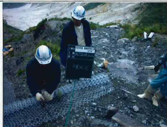
のり面保護工 金網張工
