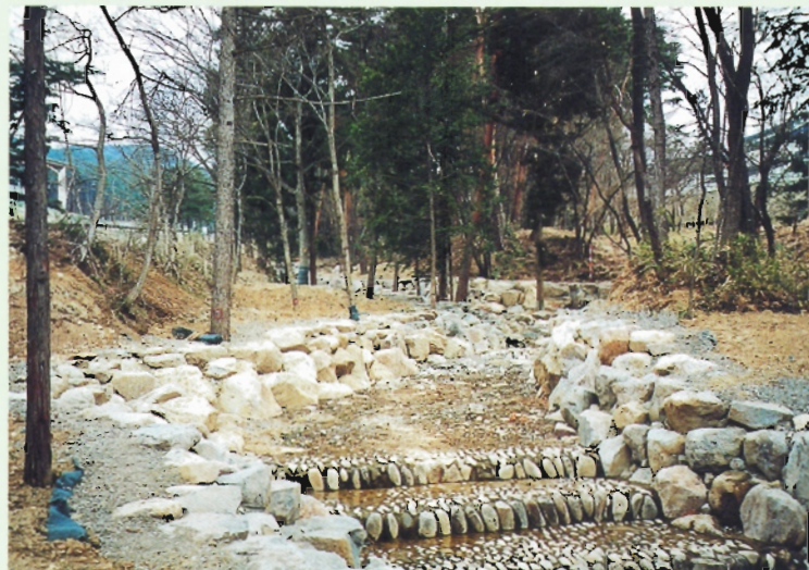
県内産(望月町)の自然石を利用し、自然景観に配慮しました。
