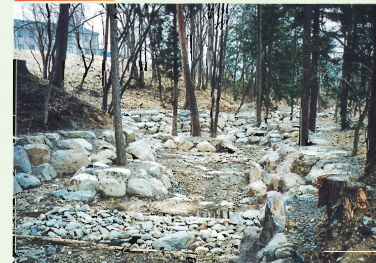
井桁の形に組んだ丸太の間に石を詰め、河床の洗掘防止をはかりました。
