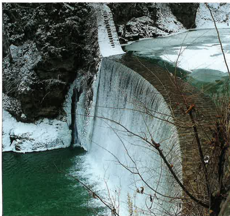
坪根砂防ダム
