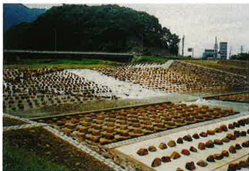
床固工魚道部
