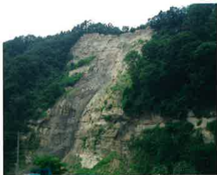
崩壊は現在も続いている。 2007年7月撮影
