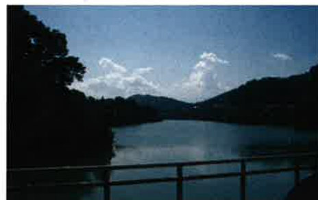
上流 ダム湛水池
