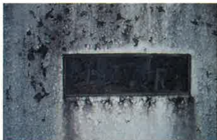
現橋の橋銘版
