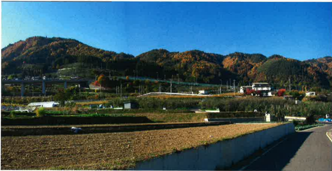
全体的に植生は回復しているが、佐野川沿いでは現在も崩壊が多く見られる。
