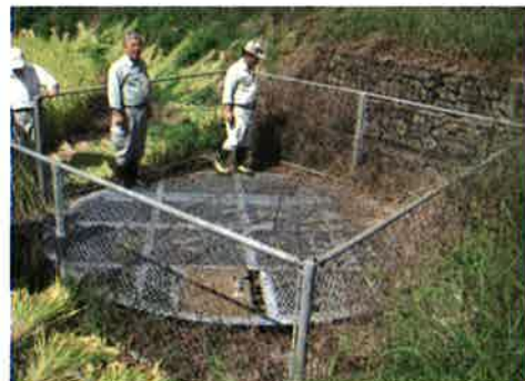
長野県で最初のライナープレートの集水井が施工された。
