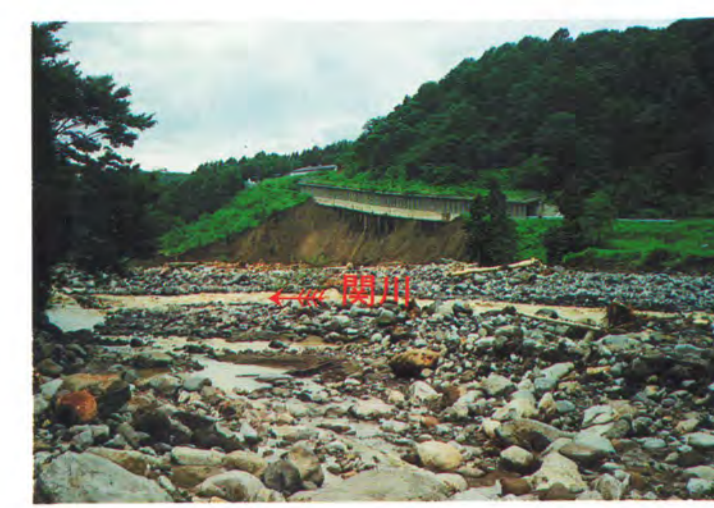
信濃町高沢(高沢スノーシェット基礎露出)
