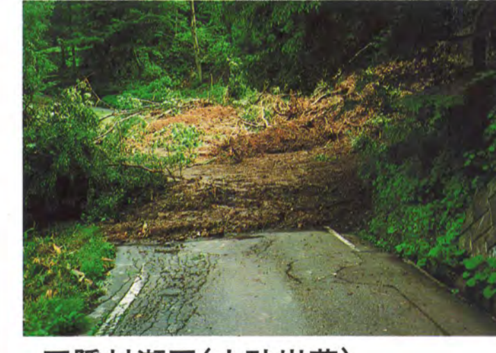
戸隠村瀬戸(土砂崩落)
