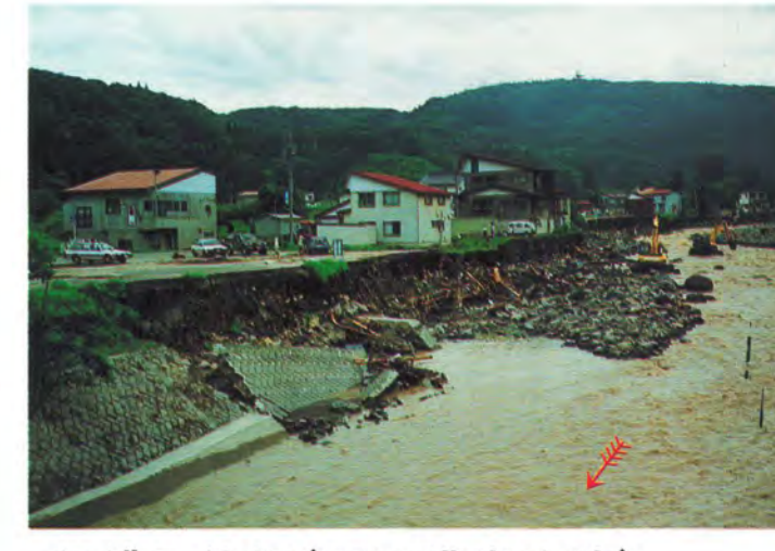
信濃町熊坂(関川護岸決壊)
