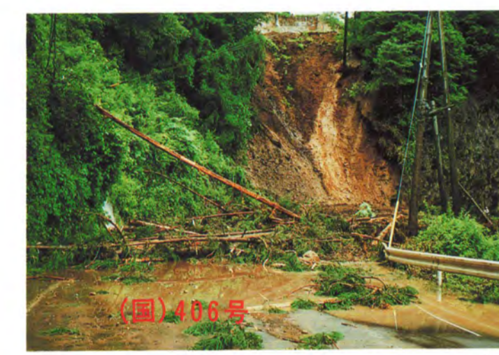
戸隠村中峰(土砂崩落)
