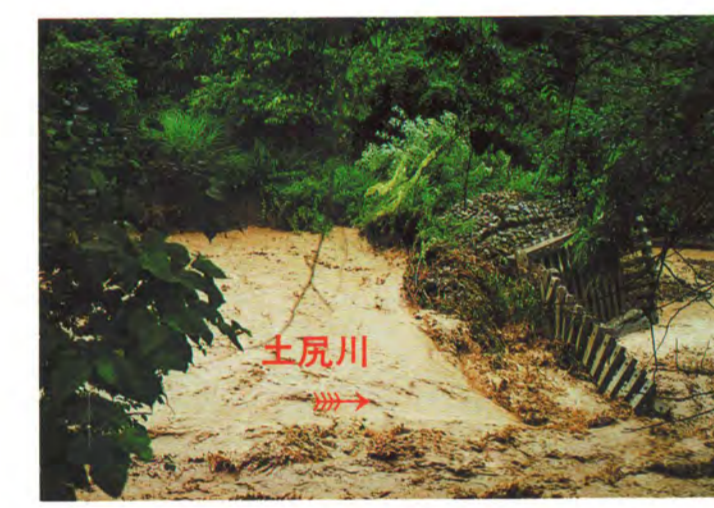
小川村(土尻川護岸決壊)
