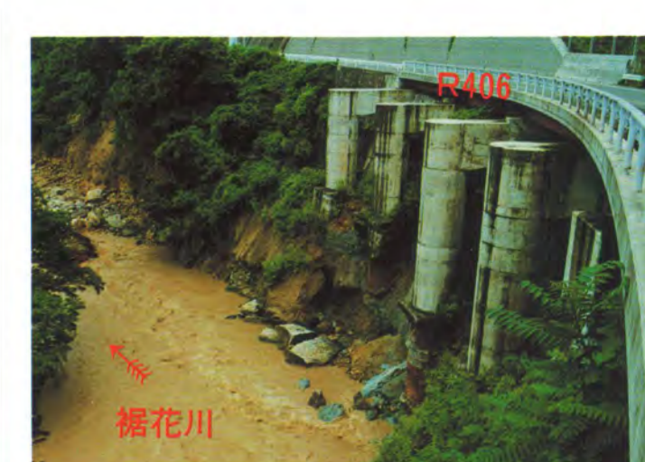
長野市百瀬(棧道橋基礎露出)
