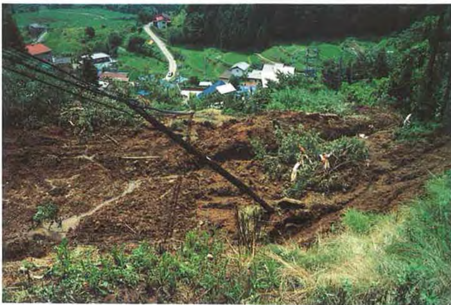
▲長野市芋井桜 地すべり土塊が民家をおそう
