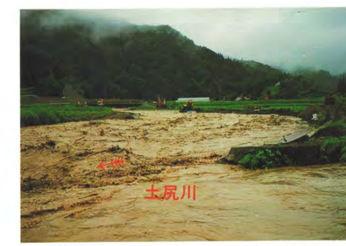
中条川(土尻川護岸決壊)
