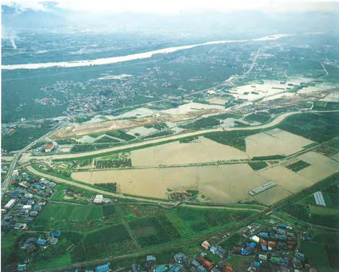
▲豊野町 浅川の氾濫により浸水した工事中新幹線車両基地
