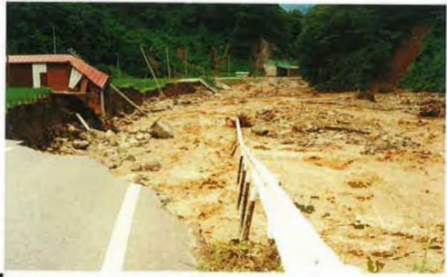
▲7/12 戸石 被災状況
