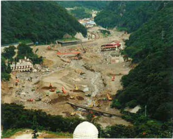
▲ 応急工事 (H7.9中旬)
