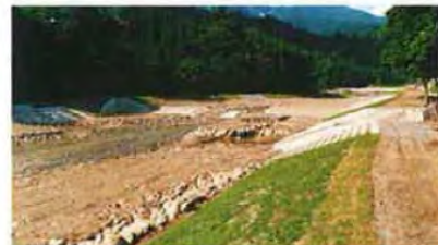
▲堂田橋より上流 完成 (H9.8月)
