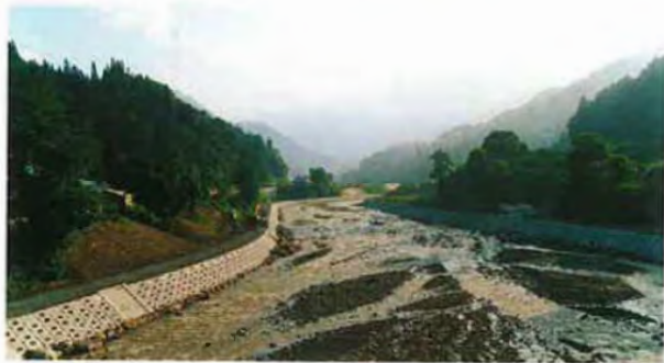
▲中谷橋下流 完成 (H9.8月)
