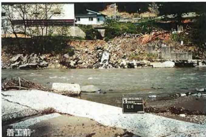
一級河川 姫川 小谷村月岡鉄橋中
