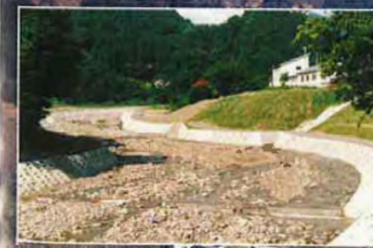
▲中谷橋上流 完成 (H9.8月)
