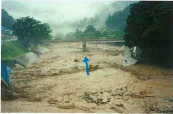
▲7/12 中谷橋上流から下流 被災状況
