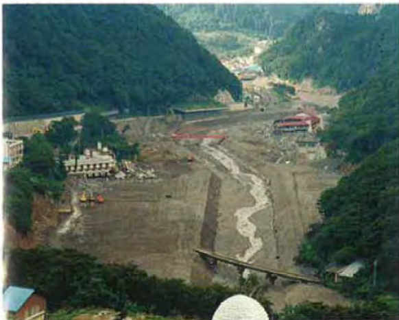
▲ 応急工事完了 (H7.9下旬)
