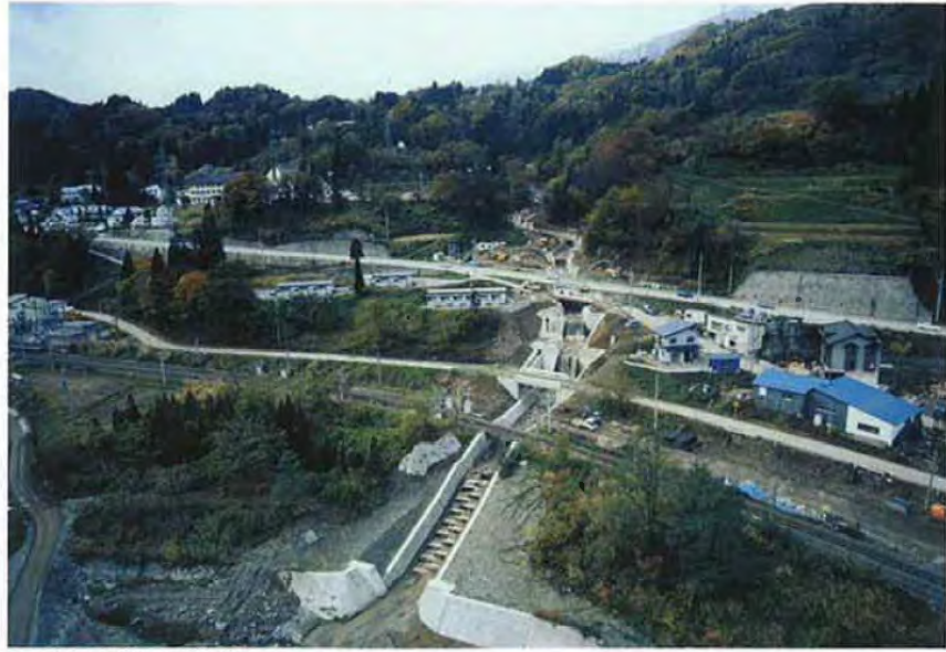
▲姫川合流部(復旧後)
