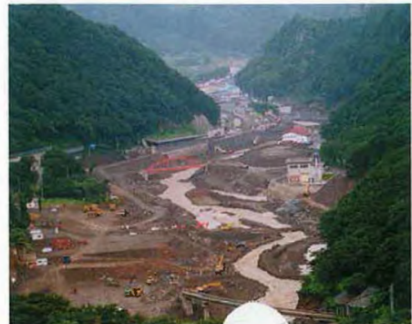
▲平成8年7月上旬 工事再開
