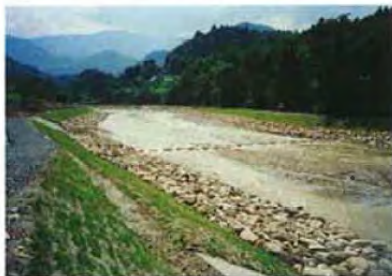
▲中谷川と十二沢の合流部 完成 (H9.8月)
