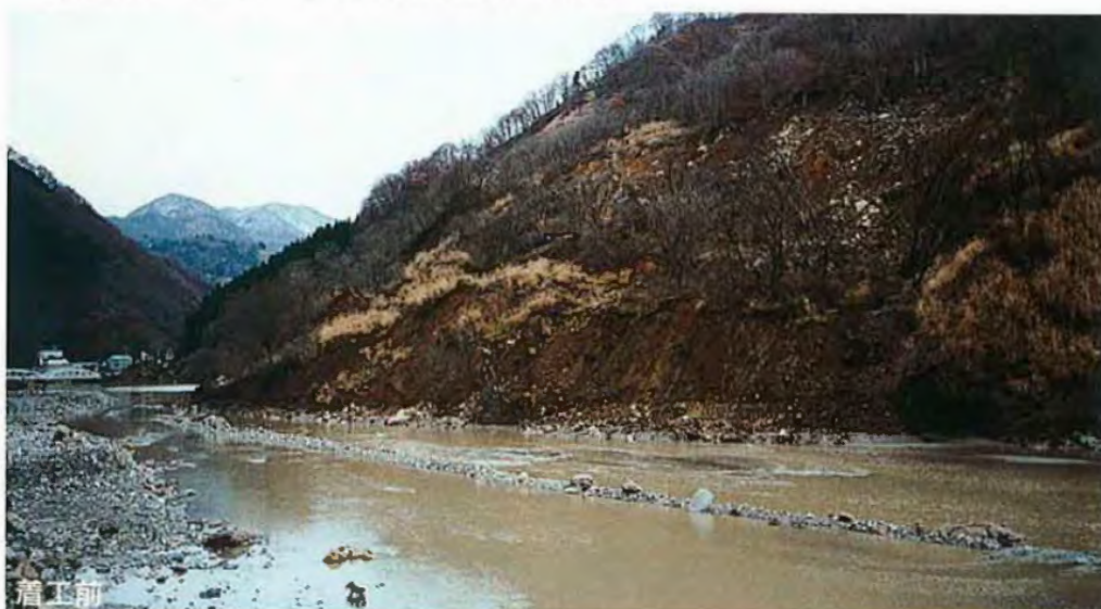
一級河川 姫川 小谷村川尻洞門右岸
