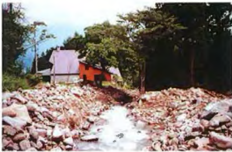
▲被災状況 (H7.7)
