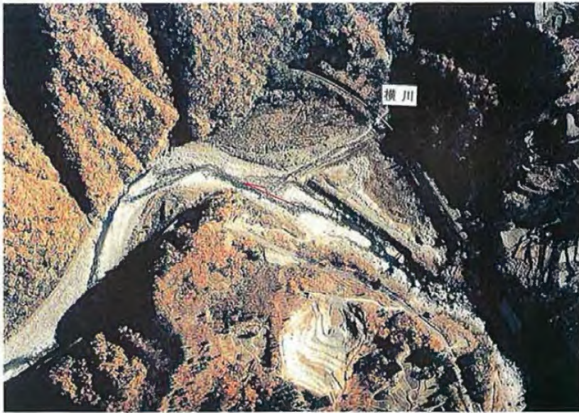
▲被災前の現況(横川合流付近) (H元.11)
