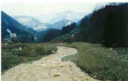
▲河道掘削 応急 (H7.12月)
