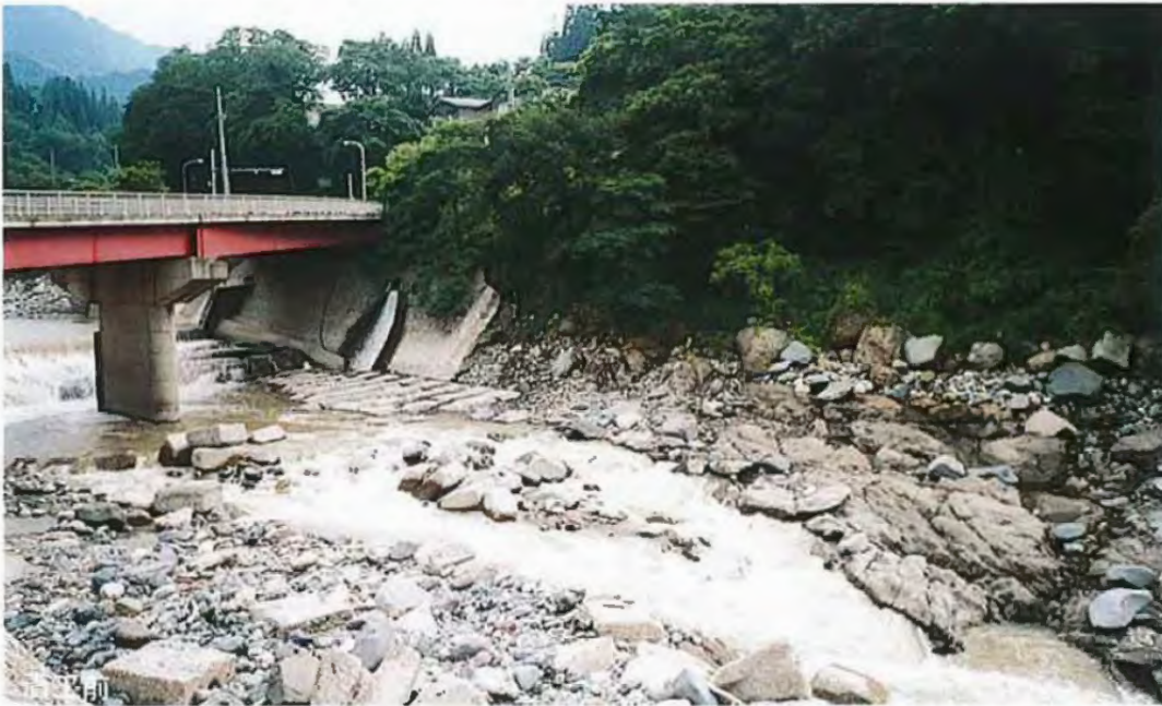
一級河川 姫川 小谷村月岡鉄橋下
