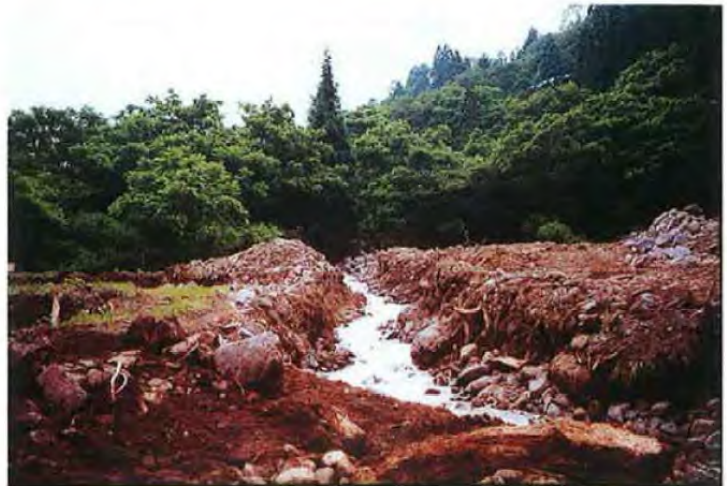
▲被災状況 (H7.7)
