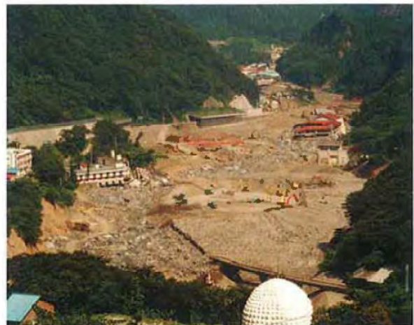
▲ 応急工事 (H7.8中旬)
