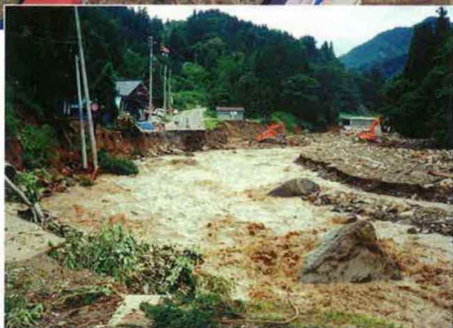
▲7/13 真木下 被災状況
