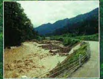
▲7/13 戸石 被災状況
