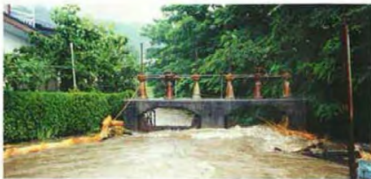
▲7/12 大町市 木崎付近 出水状況
