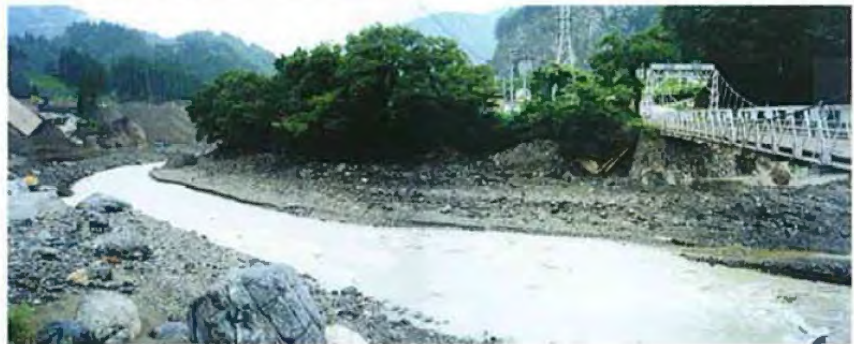
▲H7.10 応急掘削後
