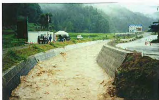
▲7/12 土尻川、出水状況 美麻村 青具
