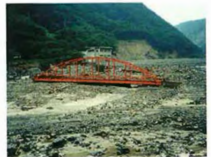
▲7/14 土砂埋そく状況
