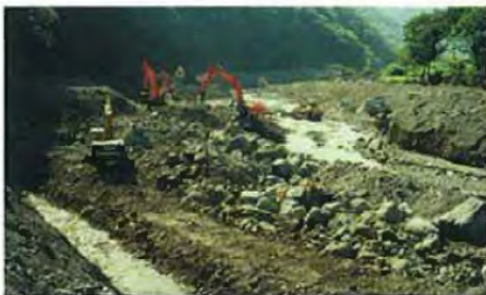
▲H7.8 応急掘削状況
