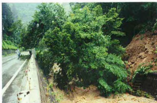
▲7/12 土尻川 切石 土砂崩落状況
