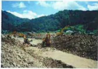
▲応急で仮河道掘削
