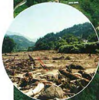
▲7/17 藤掛砂防ダム上 中谷川を土砂で埋めつくして しまった状態
