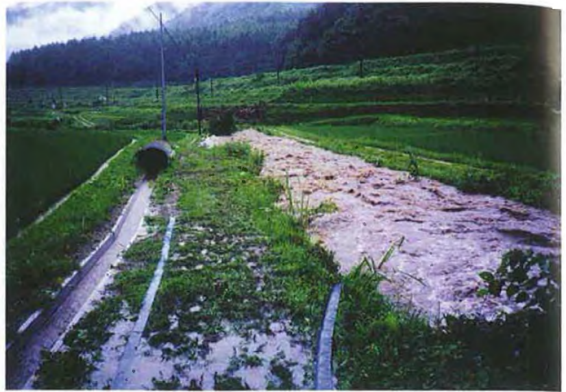
▲7/12 出水状況 大町市 平付近
