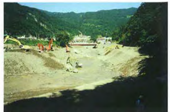
▲H7.10 応急掘削状況
