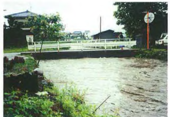
▲7/12 大町市 白塩 出水状況
