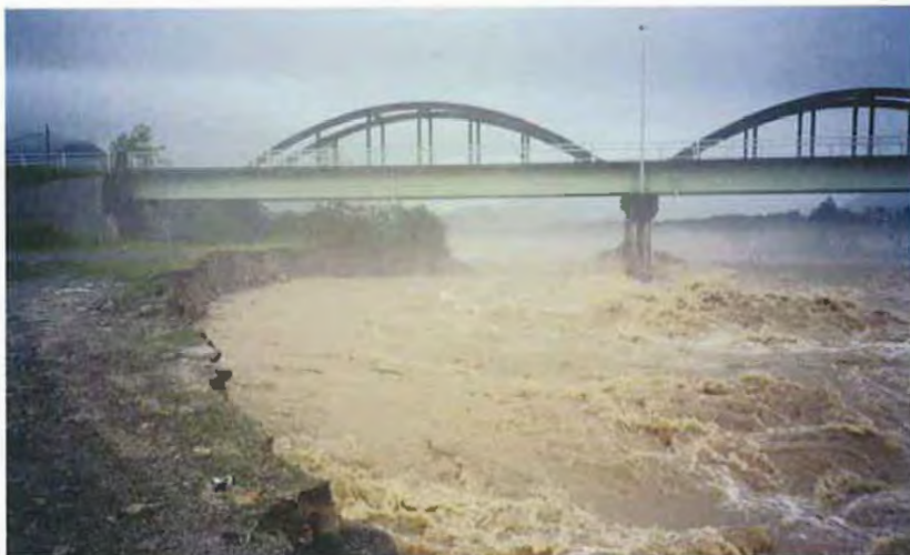
▲7/12 高瀬川、出水状況 観音橋
