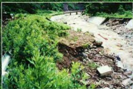
▲7/13 吉原橋上流より下流
