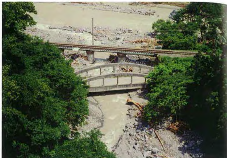
▶ 姫川合流点 (異常埋そく状況)
