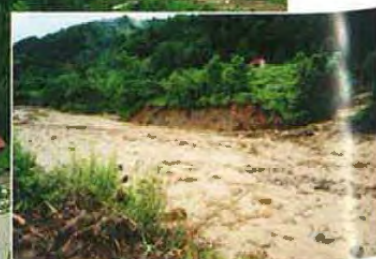
▲7/13 中谷橋下流 (耳尾沢との合流部)
