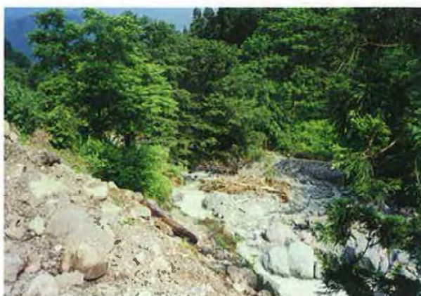
▲小谷村 沓掛付近 被災状況
