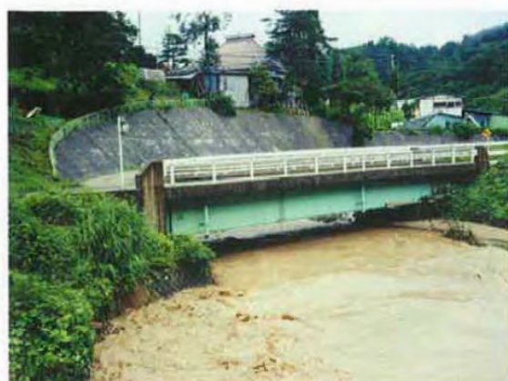
▲7/12 土尻川、出水状況 長野大町線 万中橋
