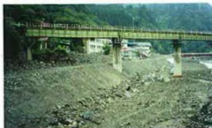
◀H7.9 仮掘削状況
