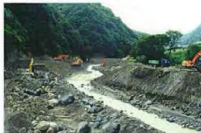
▲H7.8 応急掘削状況
