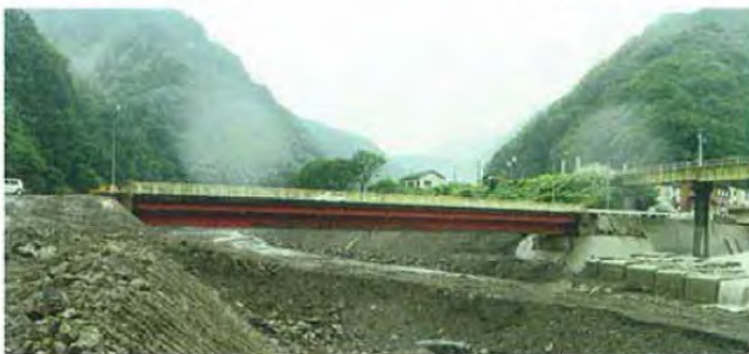
▲H7.10 応急掘削後
