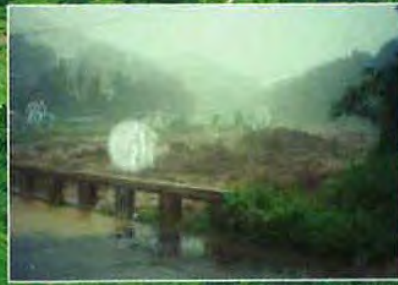
▲石原橋出水状況
