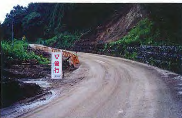
▲7/13 コウシ沢 土砂排土完了
