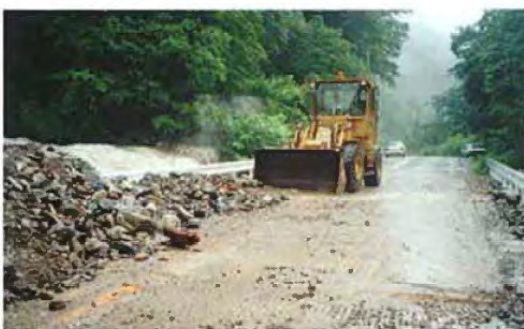
▲土砂排土状況 (7/13 撮影)
