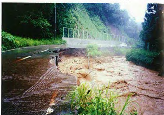
▲藤平 7/12出水、路肩欠壊
