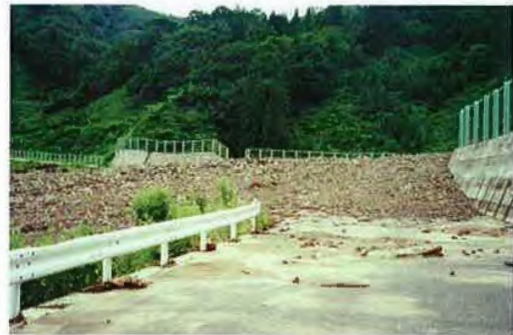
▲7/12 押立沢土砂流出状況
