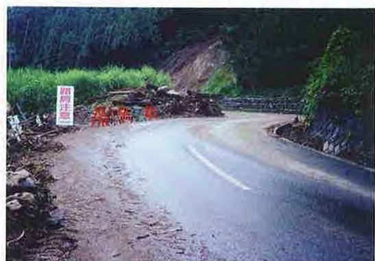
▲7/13 コウシ沢 土砂排土完了
