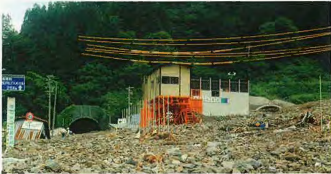
▲湯原2号トンネル
