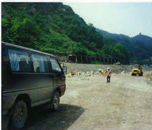
▲8/6 河川内へ仮道設置(中間部)
