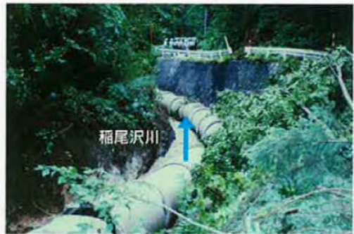
▲7/15 浸食防止のため、ヒューム管設置
