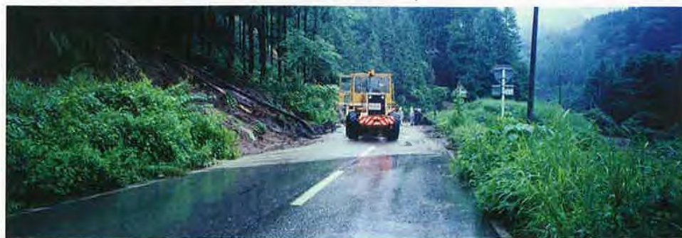
▲7/12 コウシ沢土砂排土状況
