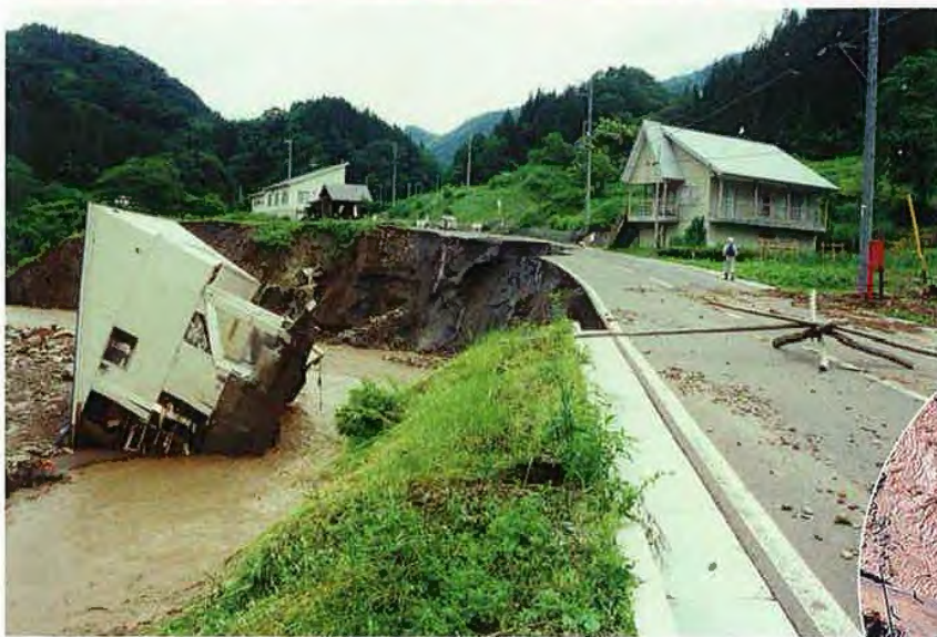
▲7/12 護岸流失、小谷村除雪基地流失
