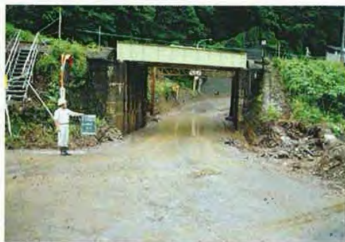
▲7/18 排水、排土完了
