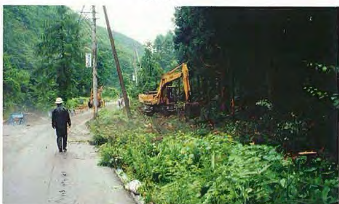
▲7/13 仮道施工状況
