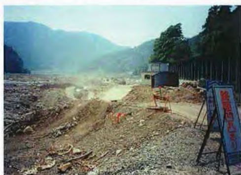
▲8/6 河川内へ仮道設置(島温泉入口)
