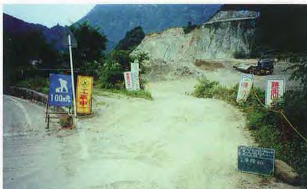
▲8/6 河川内へ仮道設置(小谷橋左岸入口)
