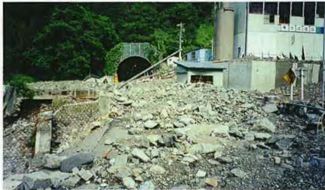
▲7/12 国道埋没状況 湯原2号トンネル
