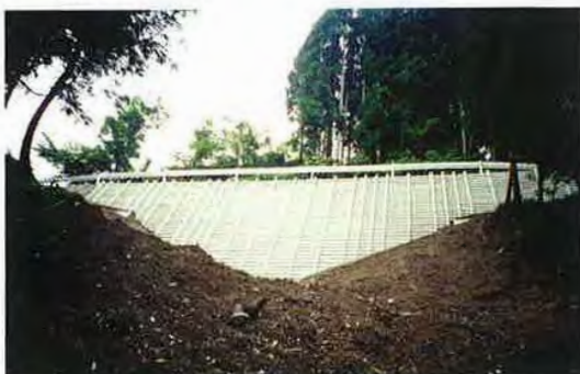
▲応急本工事完了
