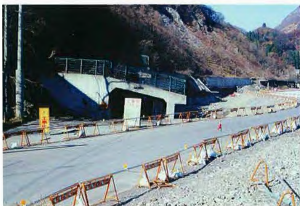
▲応急本工事完了
