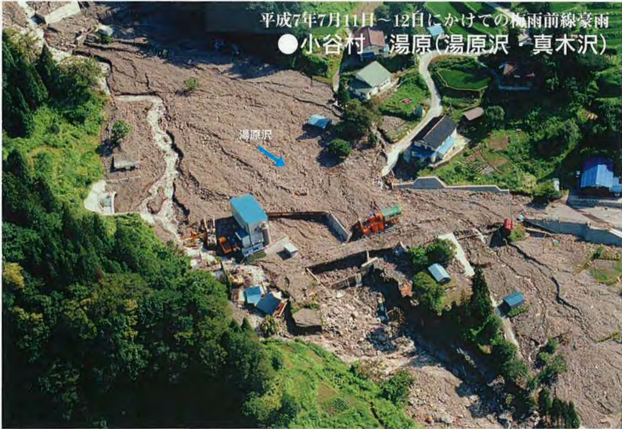
▲7/12 湯原沢土砂流出(国道及び施工中の湯原トンネルが土砂により埋没) (7/13 撮影)
