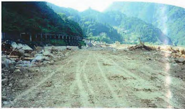
▲8/6 河川内へ仮道設置(中間部)
