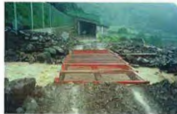
▲7/18 押立沢仮橋設置
