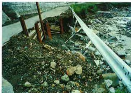
▲7/17 大なで仮土留設置
