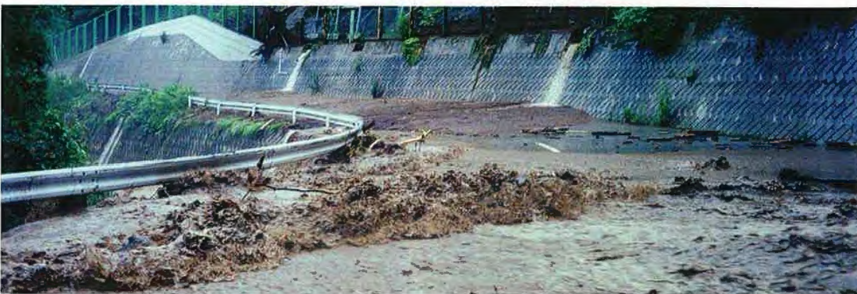
▲真二重橋下 7/12土砂流出状況
