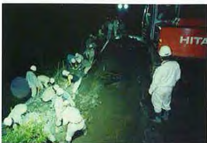
▲応急工事 (7/15 撮影)
