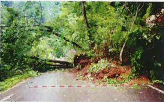
▲塩ノ川、土砂崩落状況 (7/12 撮影)
