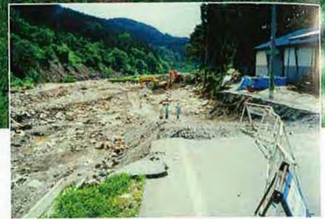
▲7/13 復旧中、車道確保
