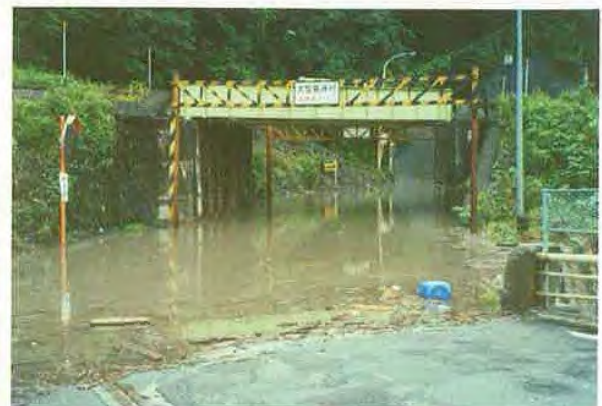
▲7/11 道路冠水状況
