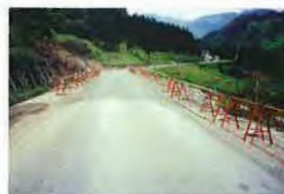
▲土砂撤去・応急復旧後
