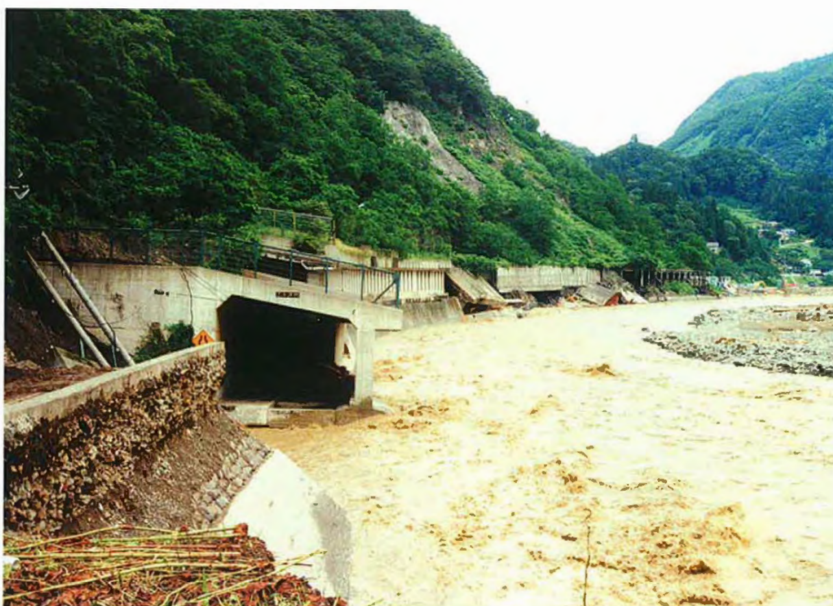
国道148号 小谷村 下寺(下寺洞門)
