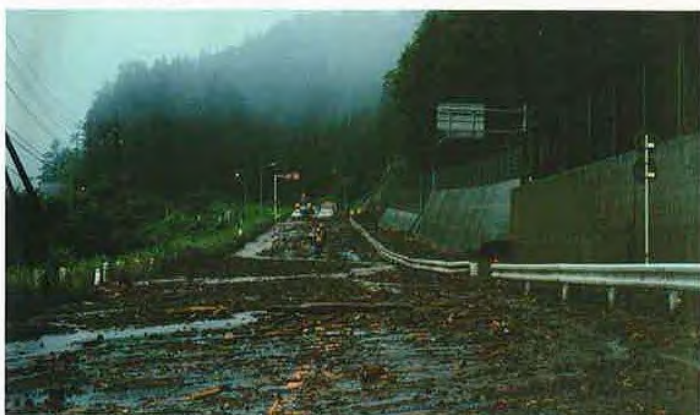
▲7/12 土砂流出状況
