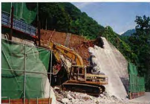
▲7/15 取壊し状況(開通16:00)
