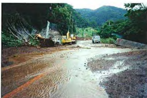
▲7/13 土砂撤去状況
