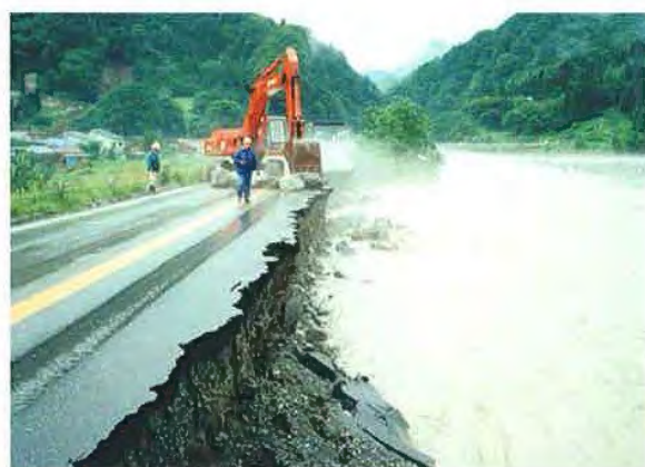
▲7/13 ブロック投入状況
