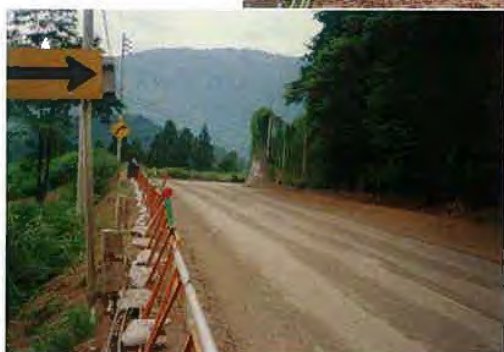
▲土砂排土状況
