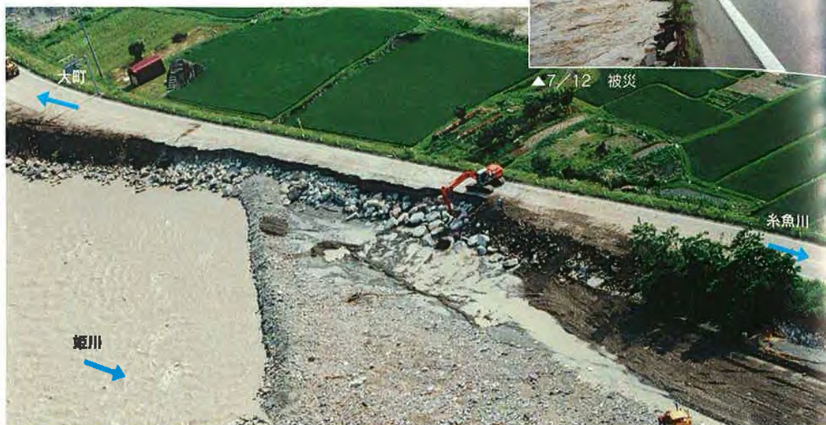
▲7/13 護床ブロックを投入し、欠陥防止・応急復旧
