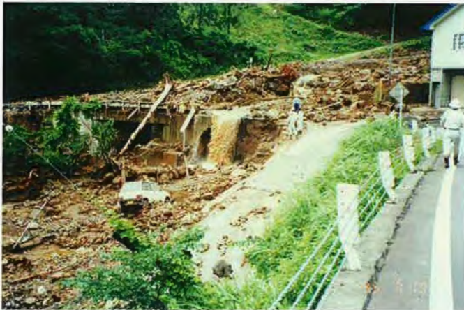
▲7/13 土砂流出状況
