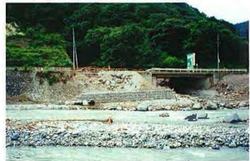
▲8/3 応急工事完了
