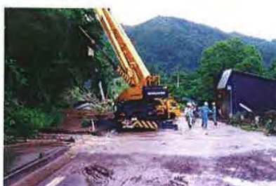
▲7/13 倒木撤去状況
