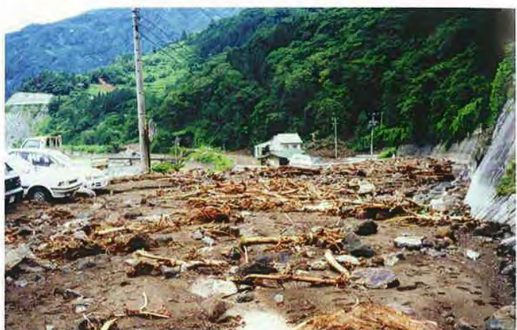
▲7/13 光明沢からの土砂による、国道埋そく
