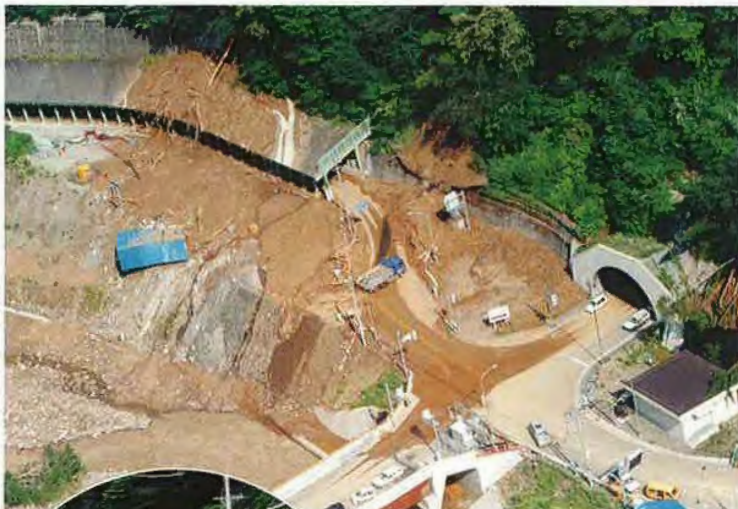
▲7/13 土砂排土、復旧作業状況(川尻交差点)
