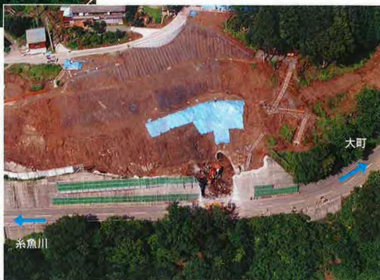
▲7/13 トンネル北坑口取壊し状況
