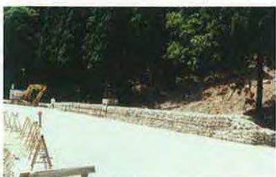
▲応急工事(仮土留)
