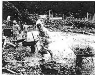
村道の土砂を取り除く北小谷村小谷地区の住民
