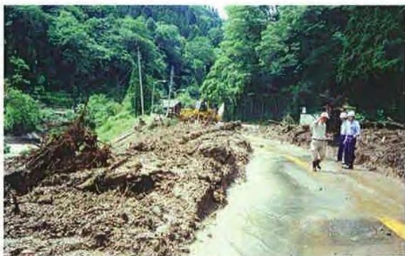
▲7/13(AM) 一車線分確保(排土指示)
