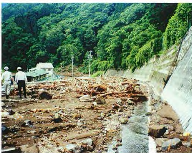
▲7/13 光明沢からの土砂による、国道埋そく
