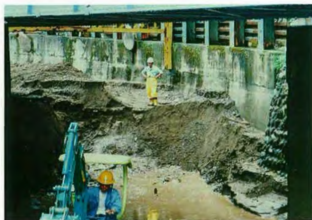
▲7/13 道路排土作業
