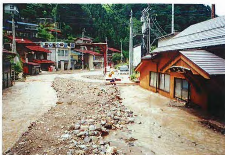
▲7/12 土砂流出状況(右側JR中土駅)
