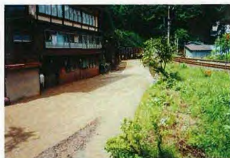
▲7/12 土砂流出状況
