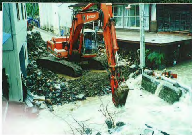
▲7/13 淀沢の河道確保、作業中
