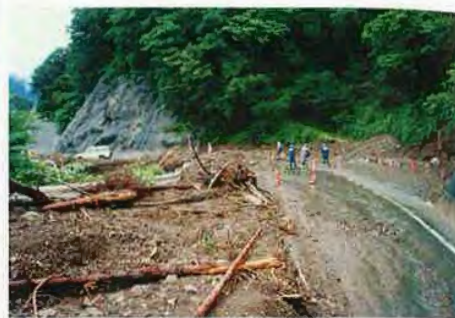
▲7/13 被災後、車線確保
