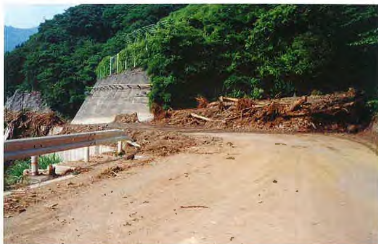
▶7/13 被災後、車線確保
