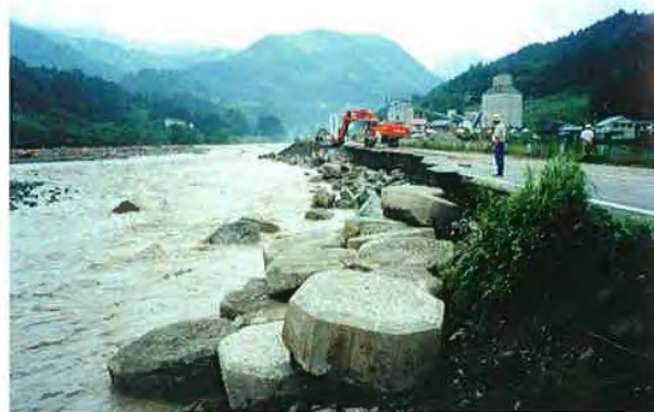
▲7/13 ブロック投入状況
