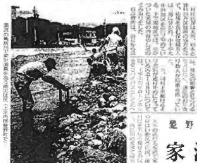
北小谷村の住民は、豪雨で被災した村道の復旧作業に懸命に取り組んでいる。13日午後3時30分
