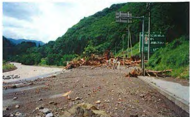
▲7/13 土砂流出状況
