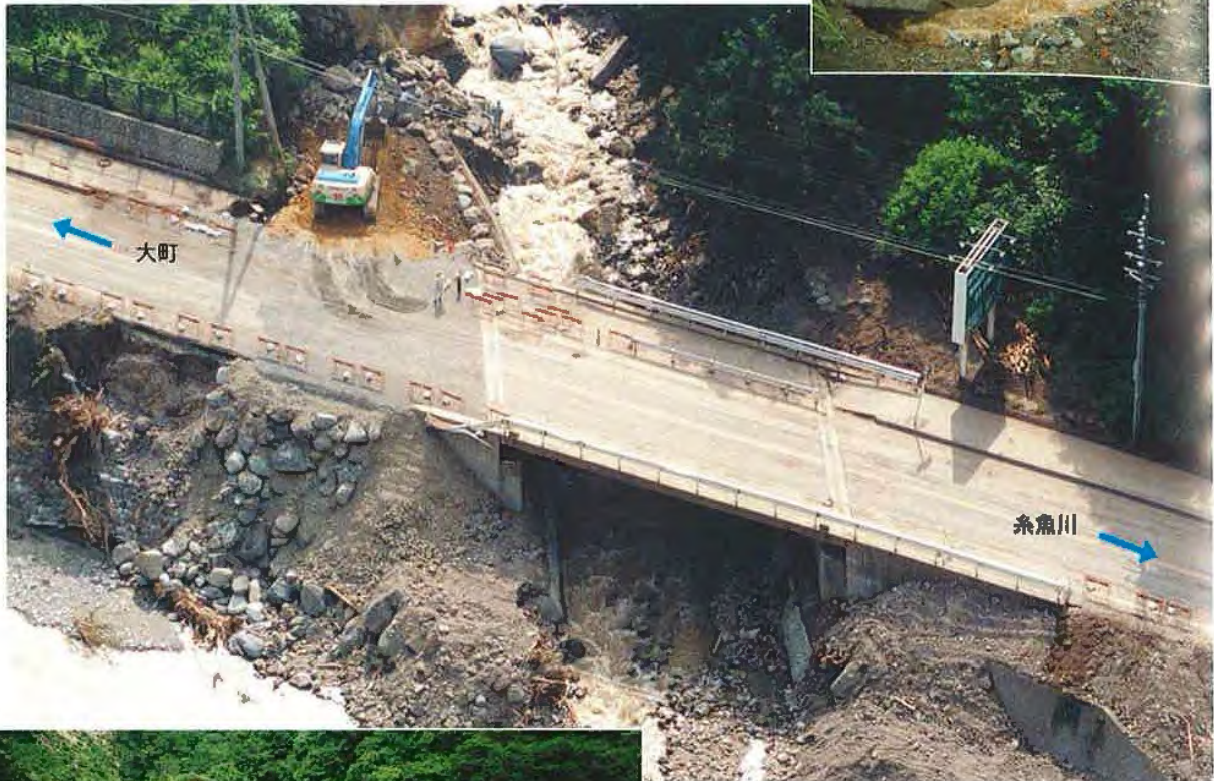
▲7/14(AM) 橋台背面盛土完了(車両通行可能となる)
