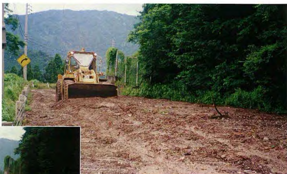
▲7/13 土砂排土状況
