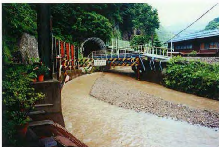
▲7/12 土砂流出状況(道路が川となる)
