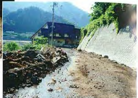
▲7/17 一車線分排土
