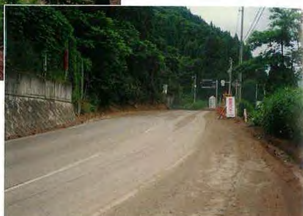
▲土砂排土状況
