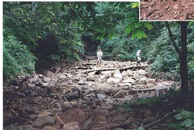
▼1号砂防ダム上流の土石流状況
