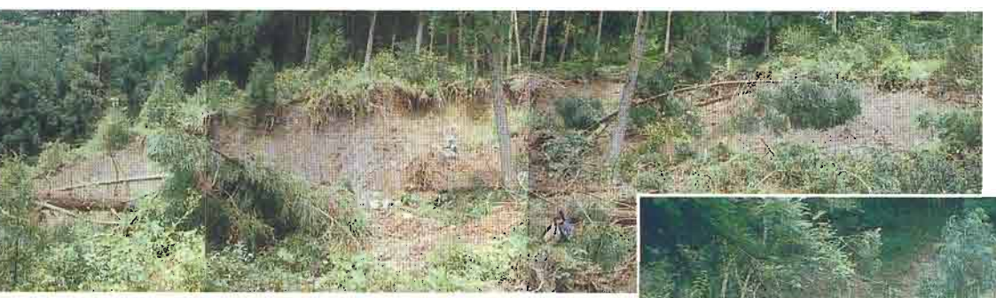
④ブロック頭部の崩落
