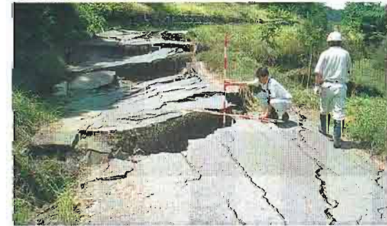
③寸断された県道の状況
