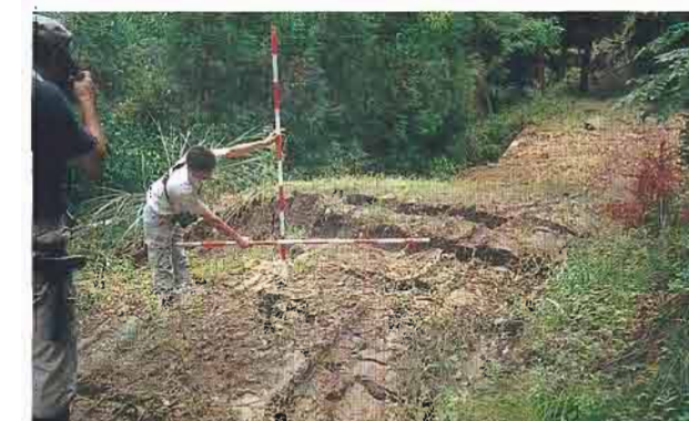
⑩末端部の押し出しによって縦方向に亀裂が発生している
