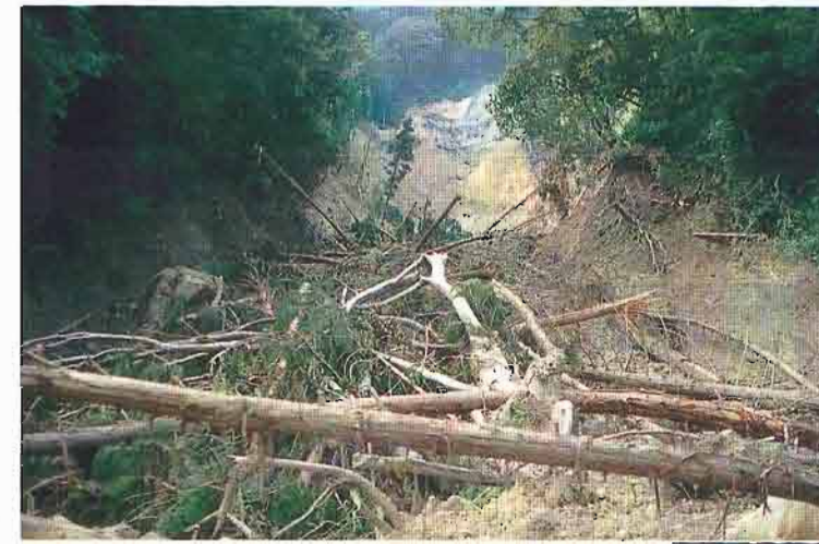
▲右岸の山腹崩壊
