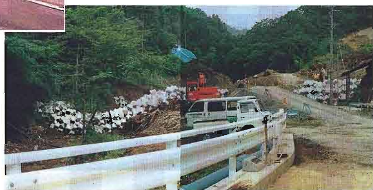
▲土砂を取りのぞき、二次災害を防止する拾ブロック
