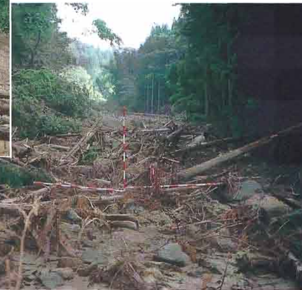
▲土砂流出河道埋そく状況
