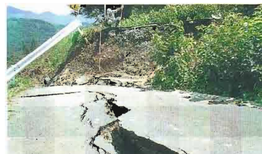
②主滑落崖の頭部(県道の滑落)
