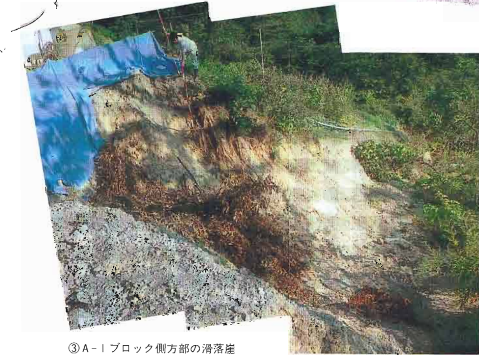
③A-1ブロック側方部の滑落崖
