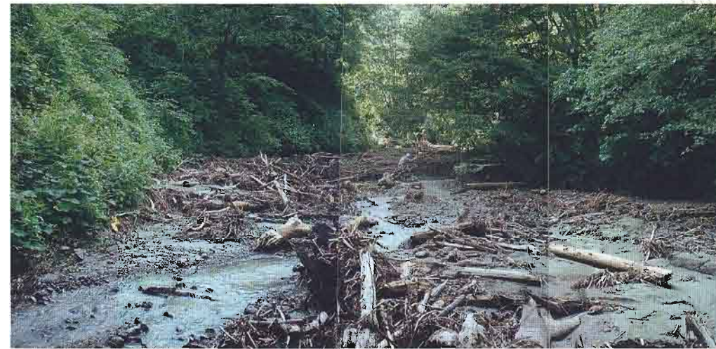
▲土砂流出による河道埋そく
