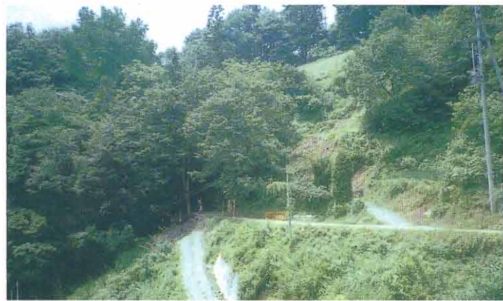
⑨ブロック頭部に発生した村道の崩壊
