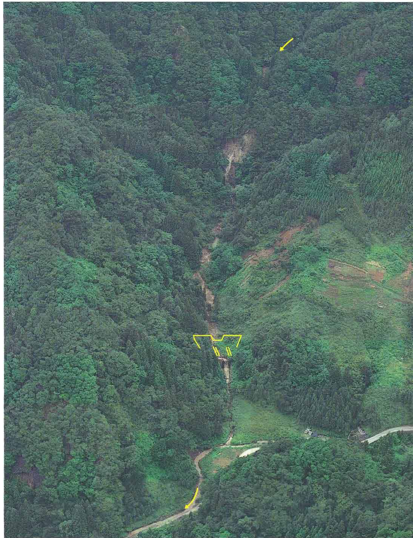
▲滝の入沢の土砂流出状況(既設を利用し、砂防ダムを新設する)
