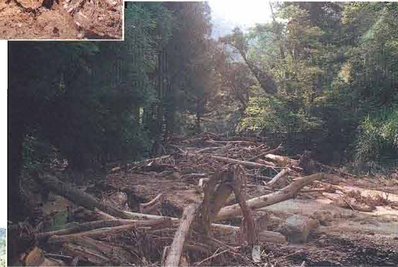
▲倒木をまき込んでの土砂流出
