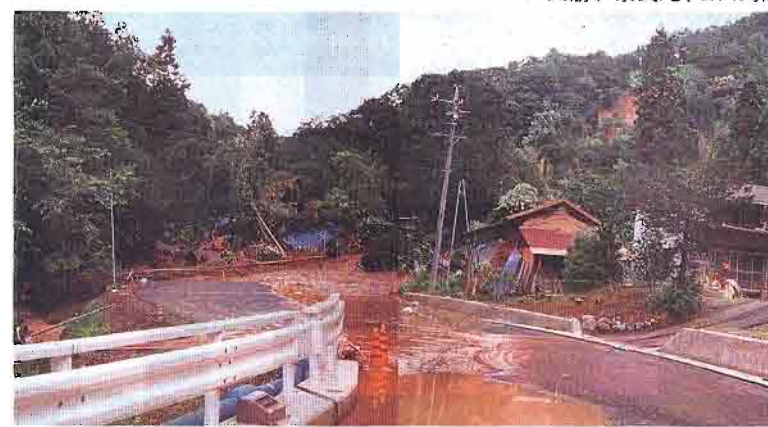
▲地すべり発生後の状況
