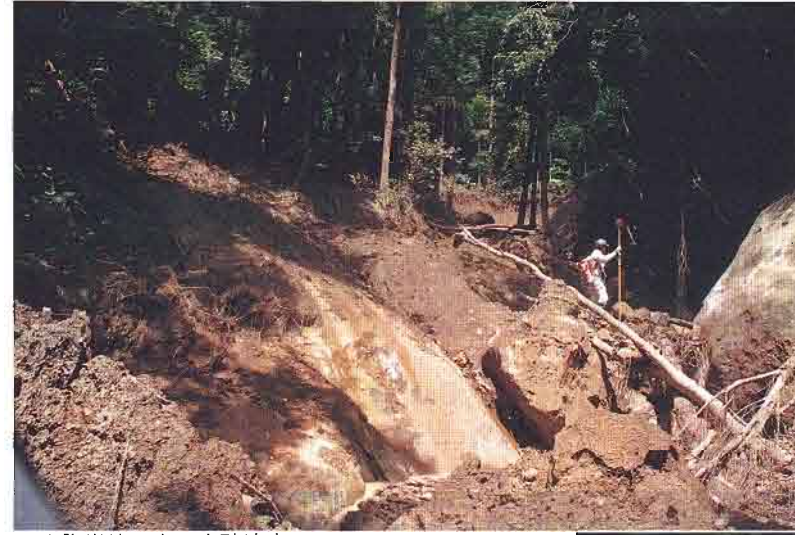
▲山腹崩壊による土砂流出
