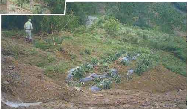
③ブロック側方の崩落土砂
