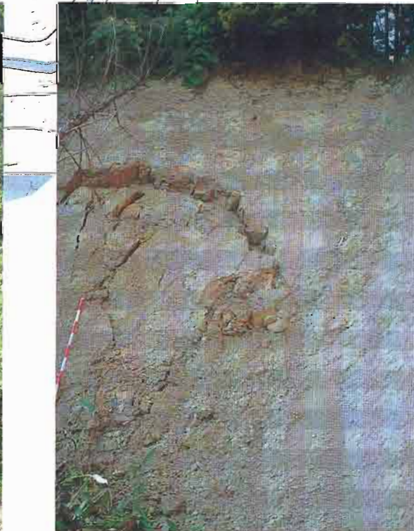
②地すべり冠頭部の亀裂
