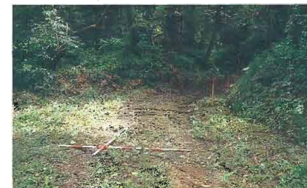
⑩地すべりブロック東側方部の状況(村道に亀裂が発生している)
