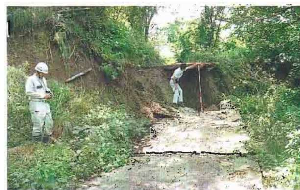
⑦主滑落崖の頭部(村道の滑落)
