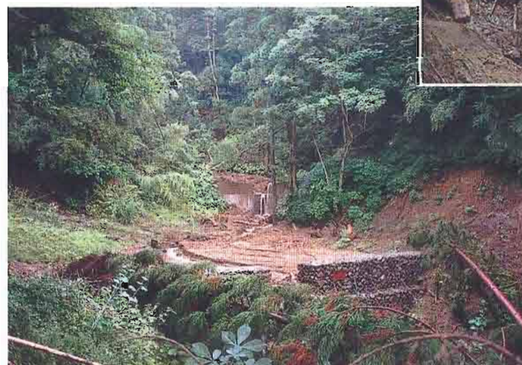
▲土石流により満砂した砂防ダム
