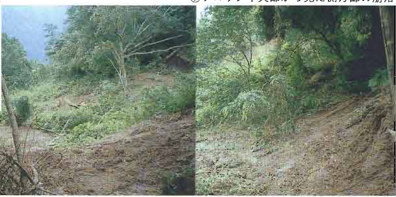
⑦ブロック中央部から見た側方の崩落
