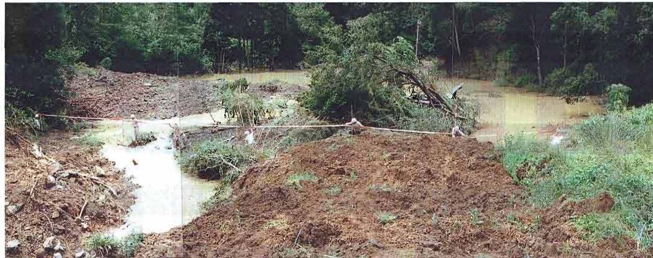
▲地すべりによってせき止められた小川沢(上流湛水)
