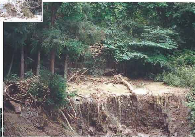
▲土石流により満砂した砂防ダム
