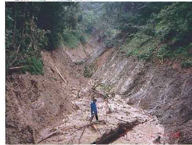
▼埋牧沢上流の山腹崩壊状況
