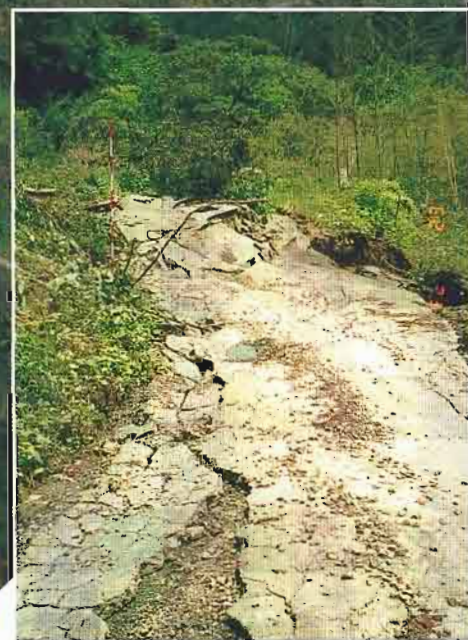
④波状に破壊した道路
