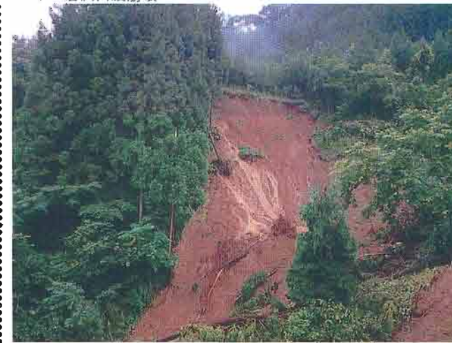
▼十二倉沢山腹崩壊
