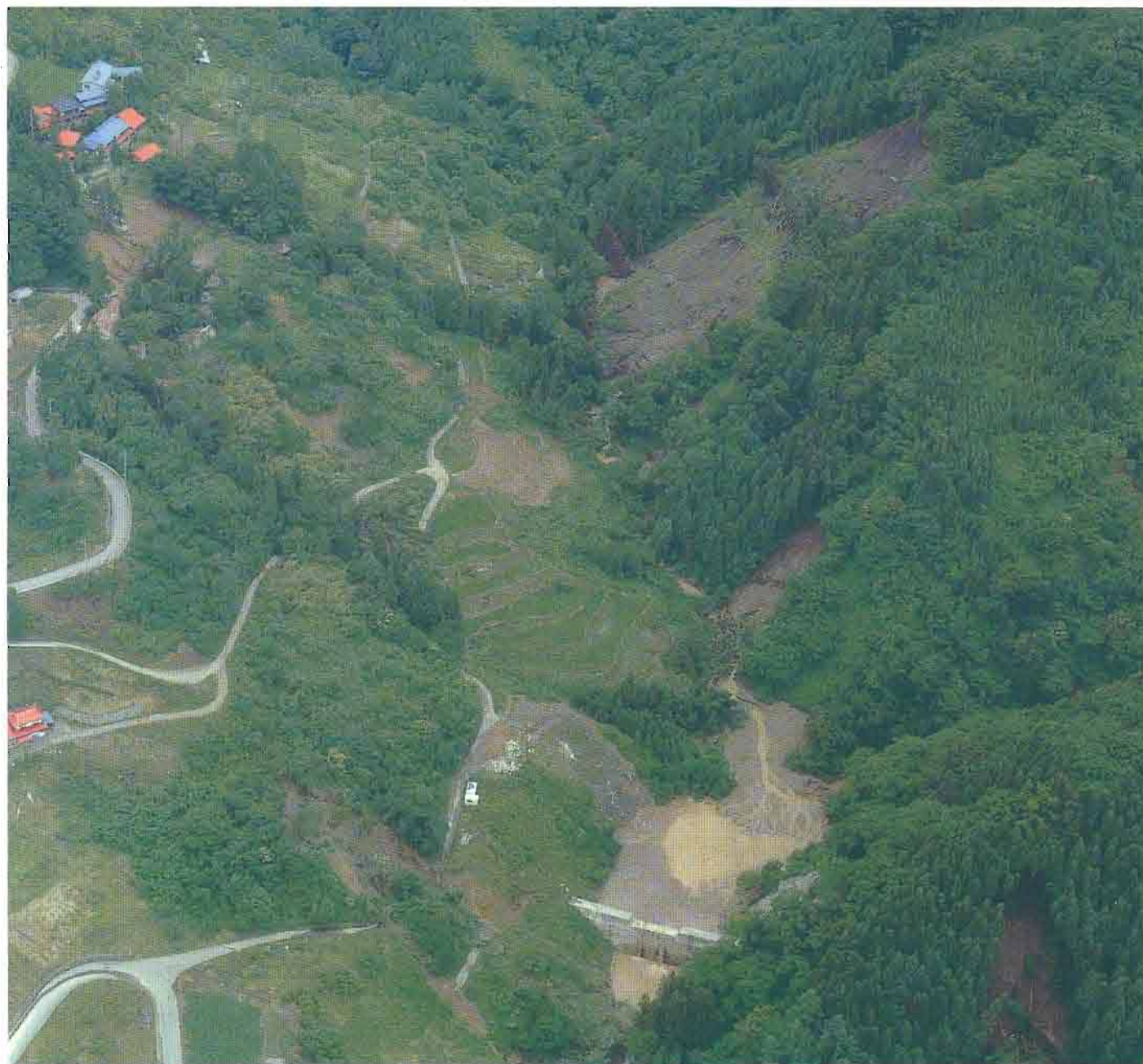
▲北尾地すべりと既設ダムによる土砂流出防止状況
