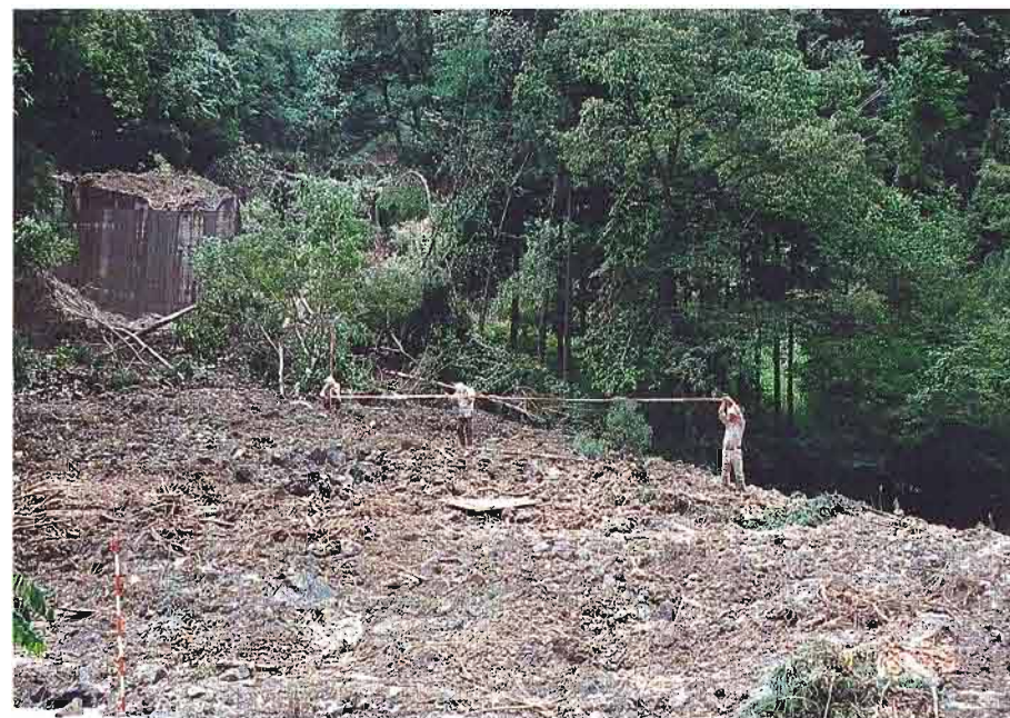
▲地すべりで右袖部を欠壊し流出した土砂
