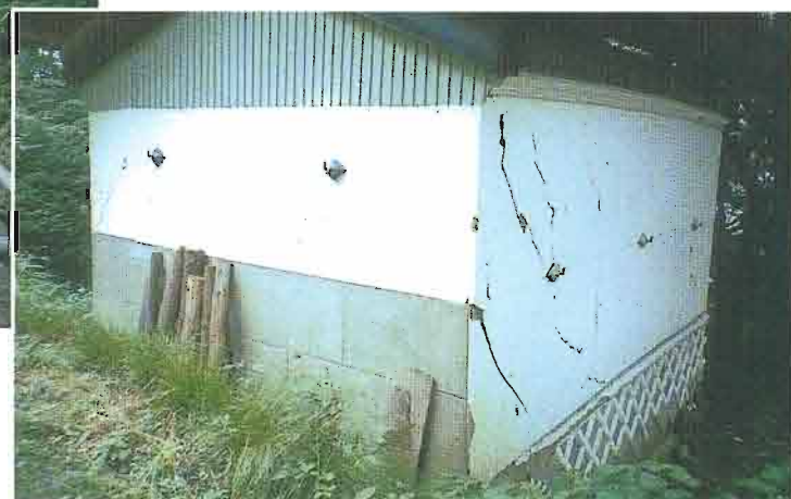
⑪地すべりにより発生した家屋の亀裂
