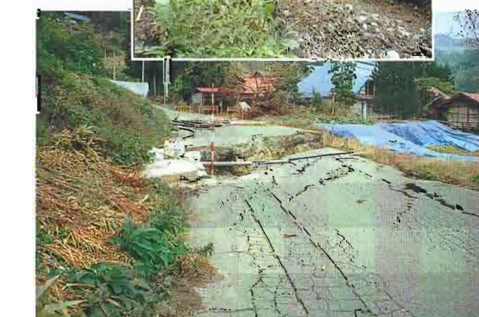
③住宅に迫る亀裂
