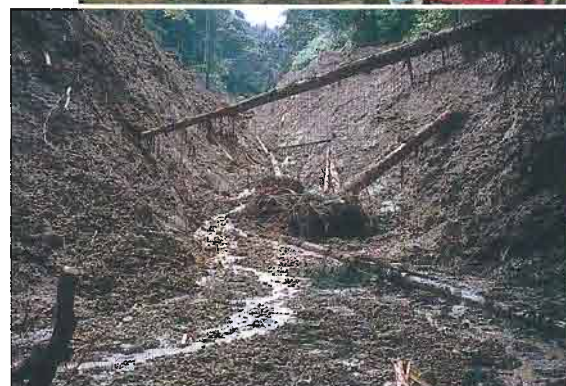
▲山腹崩壊状況
