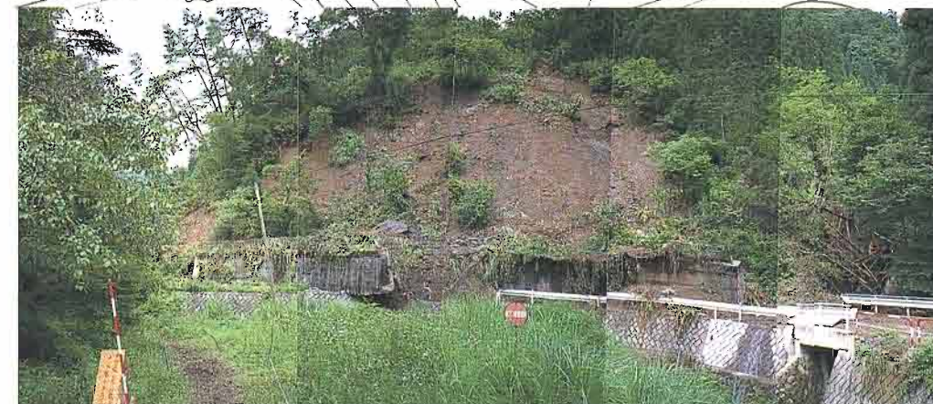
①地すべり土塊により法留擁壁が破壊
