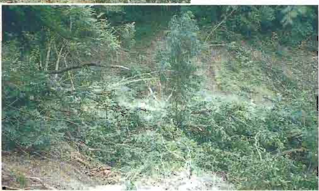
⑤ブロック側方の崩落
