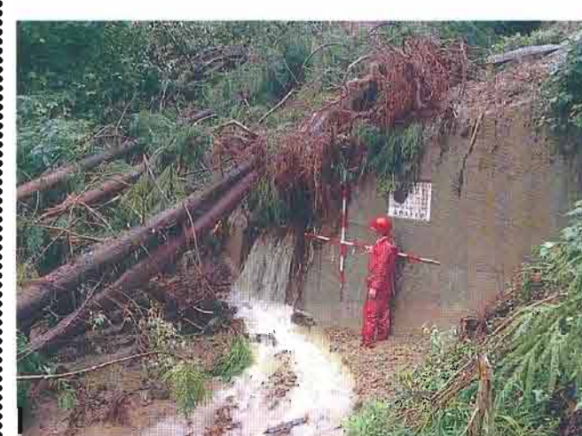
▲既設砂防ダムを飛び越えた土砂
