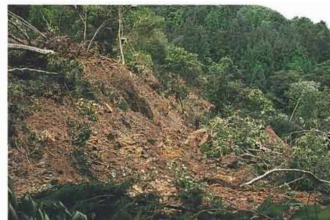
②地すべり地内の荒廃状況
