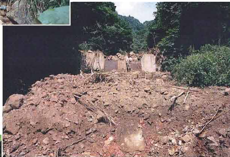
▲既設床固工を乗り越えた土石流(この下流に村道)
