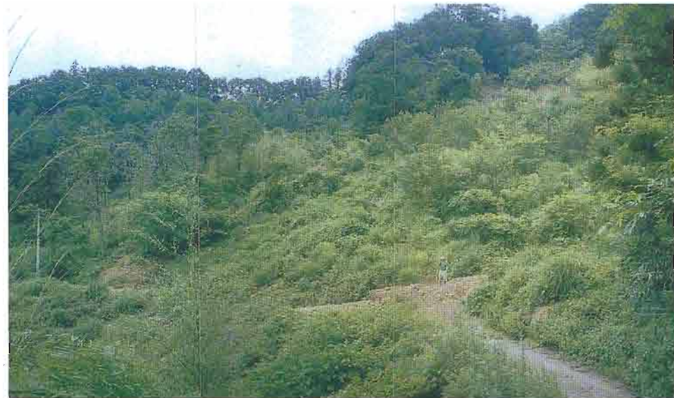
⑧冠頭部から中央部の土砂崩落による村道への押し出し
