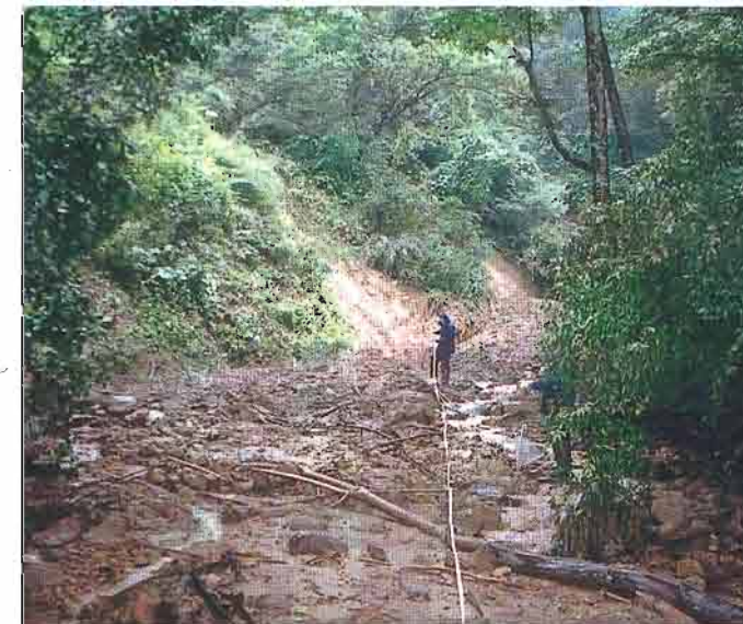
▲既設ダム上流右岸からの土砂流出状況
