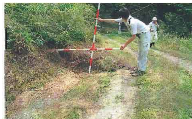
⑧村道が2m横ずれしている向う側が地すべり地内
