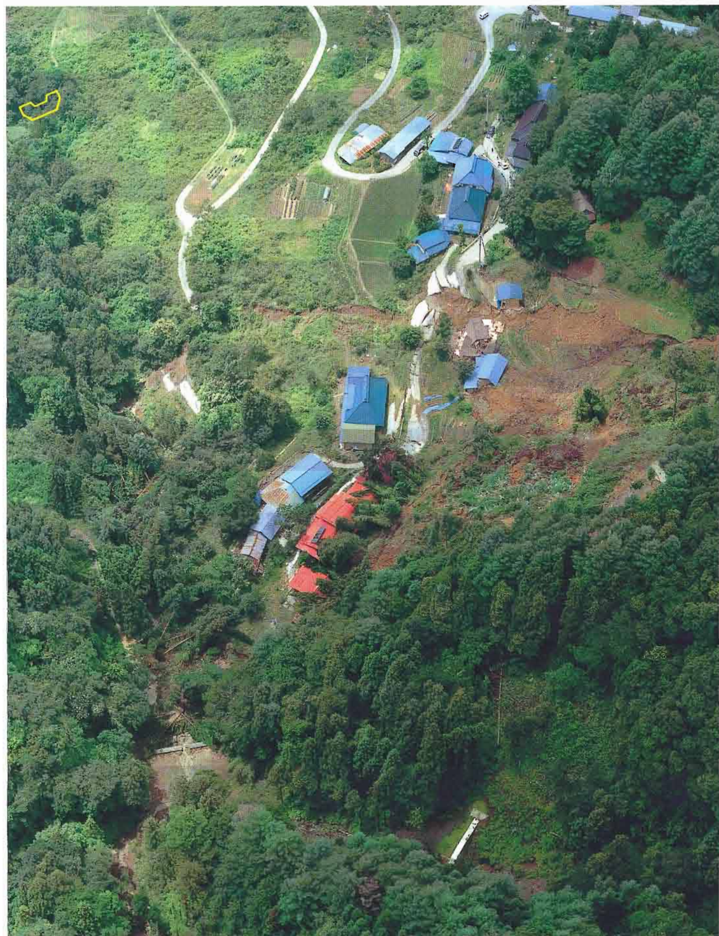
▲中牧集落を直撃し、中牧沢へ押し出した地すべりと土石流下を防止する砂防ダム
