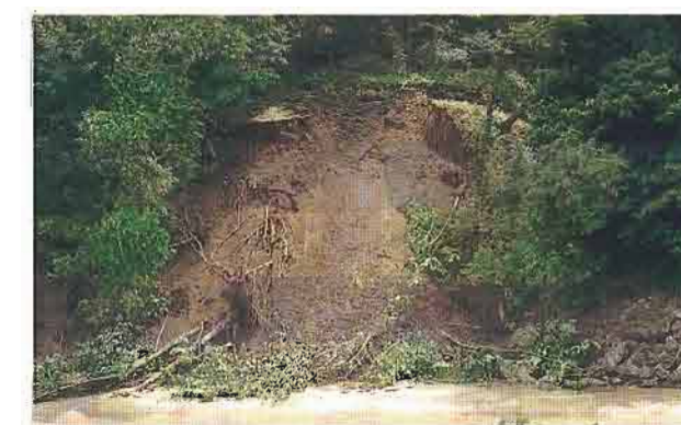
⑨末端部の崩壊状況(両側の護岸工が破壊されている。)
