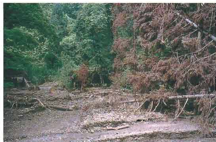
▲既設ダムと土砂埋そく状況
