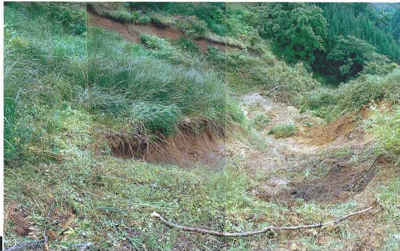
▲山腹崩壊地上部より
