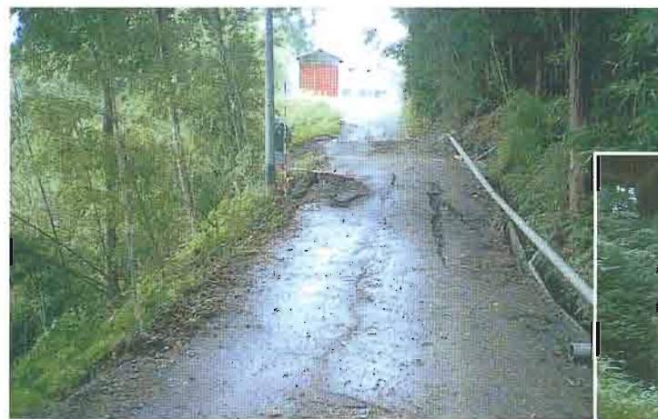
⑩ブロック側方に位置する村道の隆起亀裂
