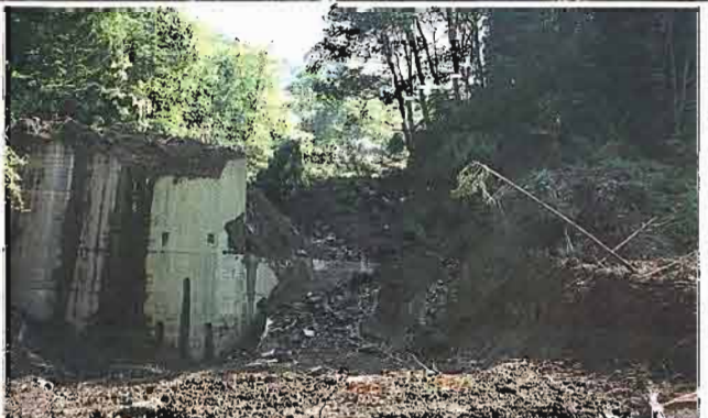
④袖が倒壊した堰堤(地すべりの押出しによる)
