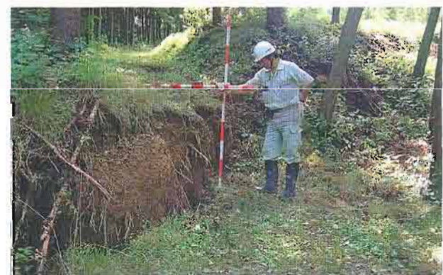
⑤主滑落部の頭部(村道の滑落)
