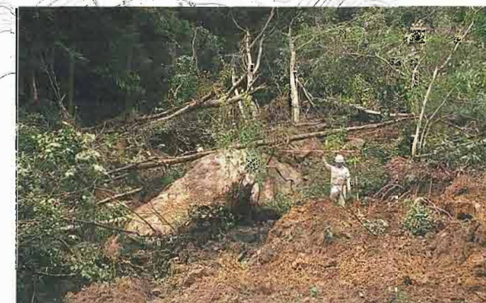
①地すべりにより流出した巨石
