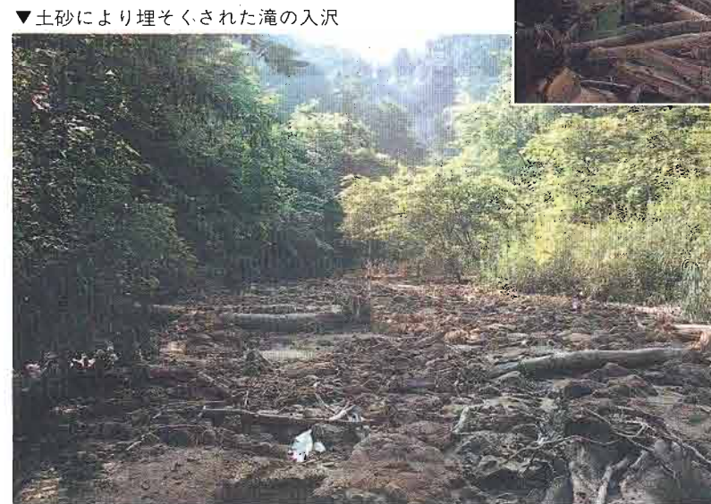
▼土砂により埋そくされた滝の入沢
