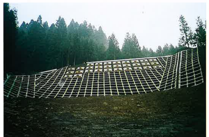
▲アンカー、法枠により法面を安定させる
