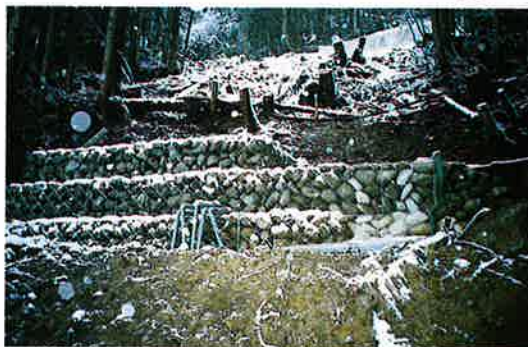
▲横ボーリング完成
