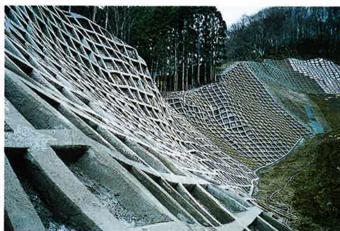
▲施工後の法面自在法枠工
