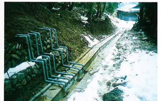
▲地下水の排出を目的に施工した横ボーリング工
