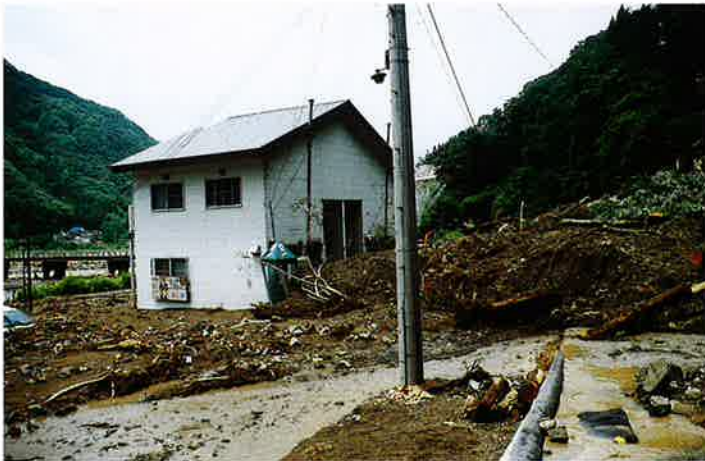
▲国道148号及び北小谷駅前土砂埋塞
