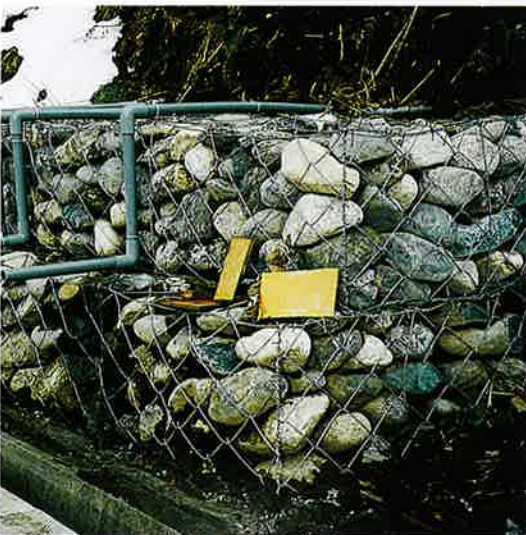
▲地下水を低下させる為の横ボーリング工
