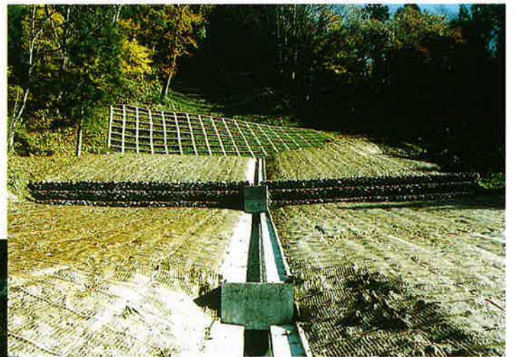
▲水路工植生ネット張完成
