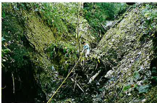
▲谷止工施工箇所
