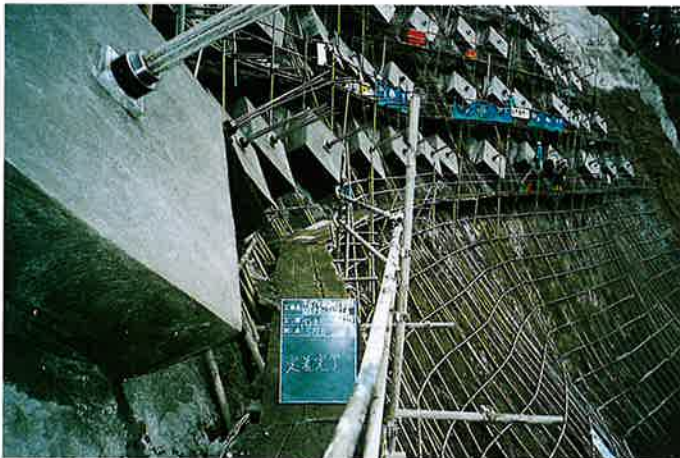
▲アンカー定着完了
