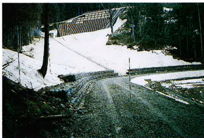
▲法枠、アンカー、水路完成
