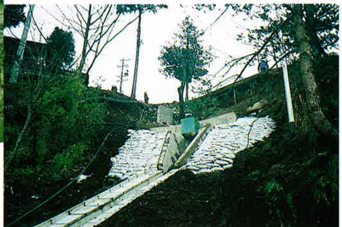
水路工整備状況 ▶
