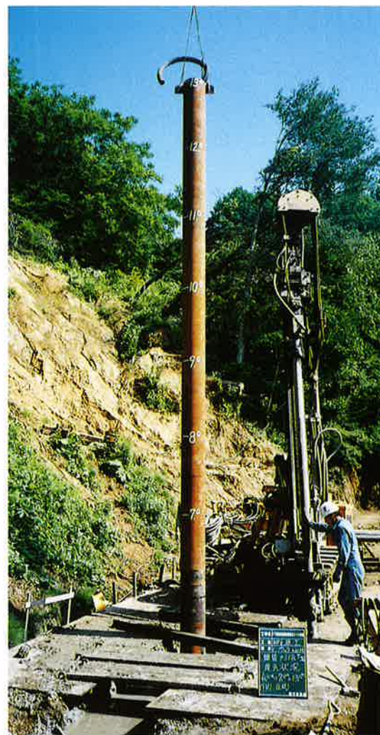
▲鋼管杭建込作業状況
