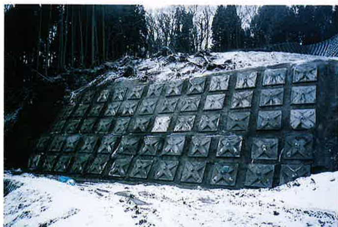
▲地すべり抑止のアンカー工完成
