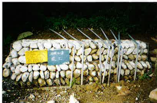
▲集水ボーリング完成
