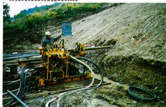
横ボーリング状況 ▶
