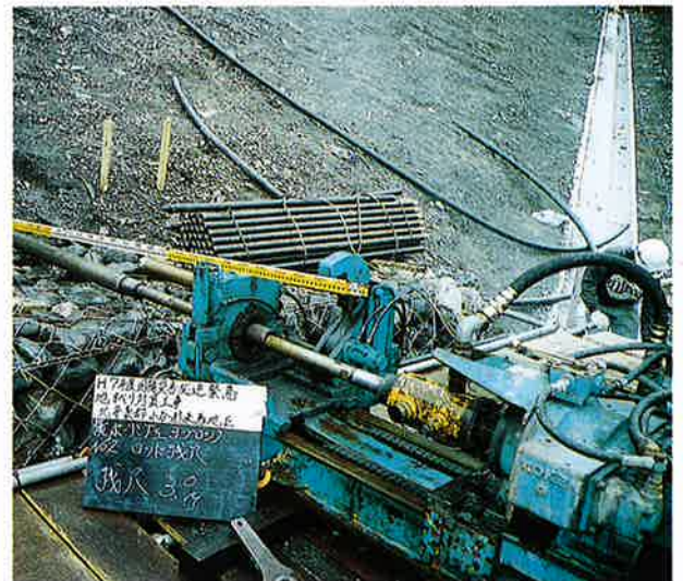
▲集水ボ-リング施工
