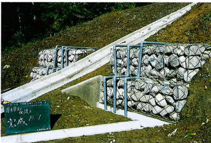
▲水路工及び横ボーリング
