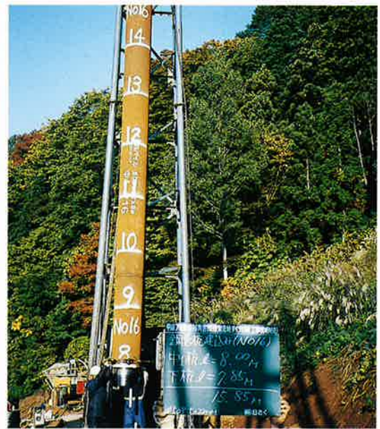
▲鋼管杭建込状況
