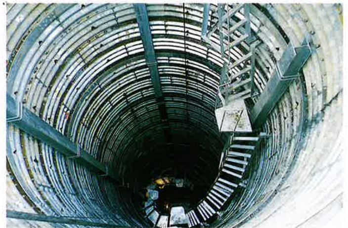
▲完成した集水井
