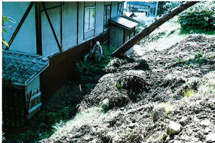
▲民家に押し出した土砂
