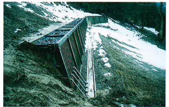
▲地すべり中間部に設置した鋼製自在枠土留工
