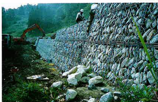
▲土留施工状況
