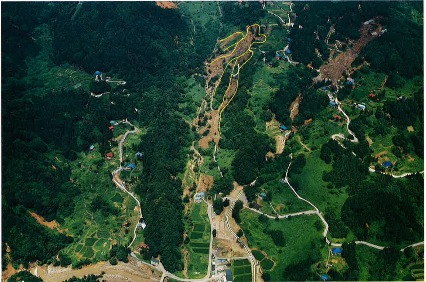
▲被災直後の状況
