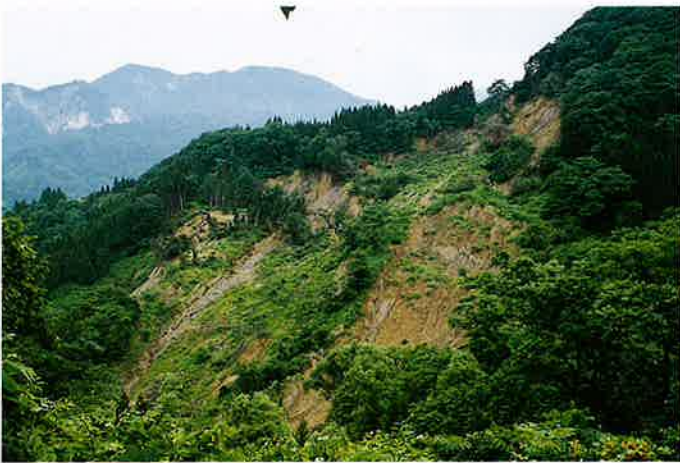
◀ 城地すべり崩壊状況
