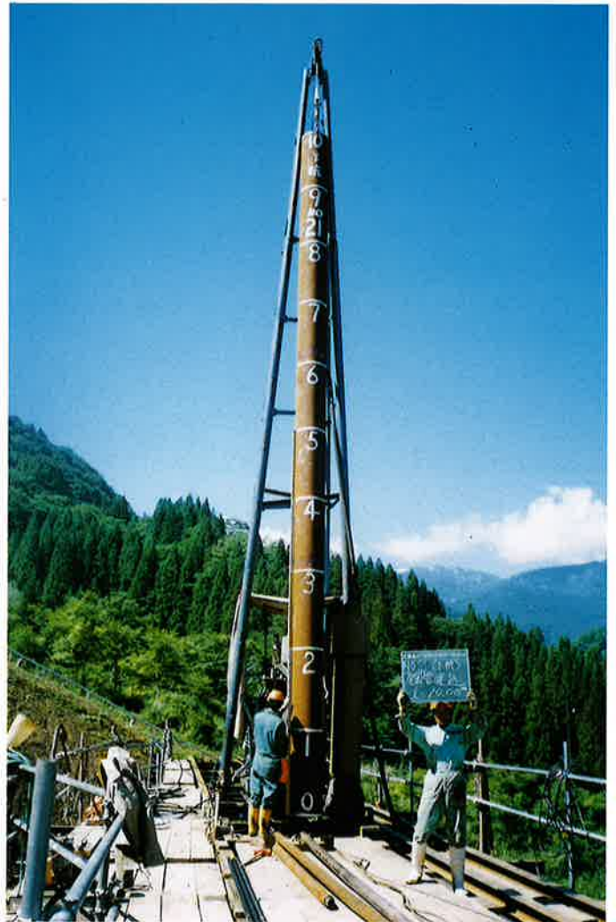
▲鋼管杭建込状況
