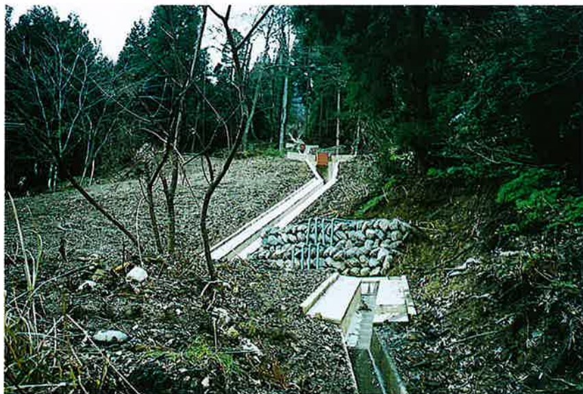
▲水路工及び横ボーリング完成
