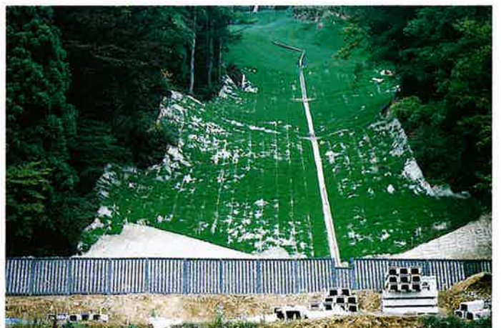
▲地すべり対策工事完成
