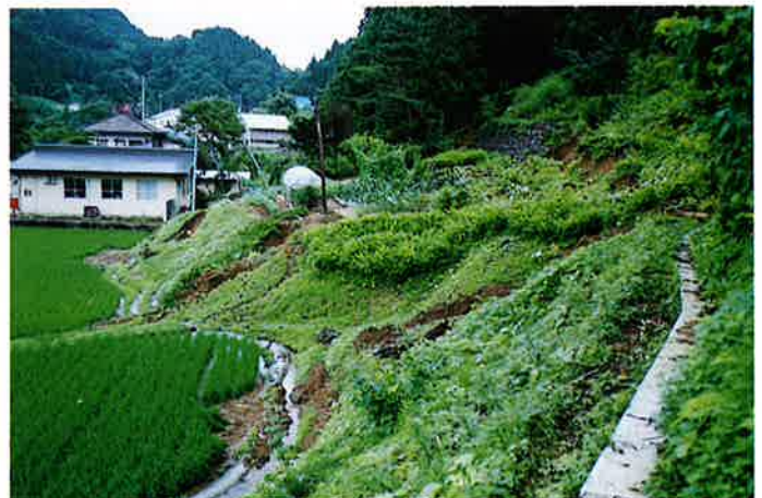
▲田畑に押し出した土砂
