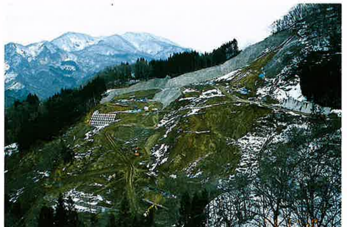
地すべり対策工事施工状況 ▶
