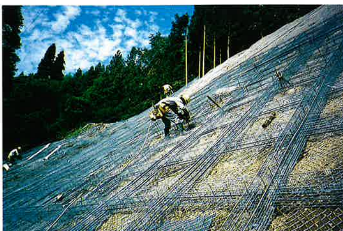
▲法枠工、命綱により施工中
