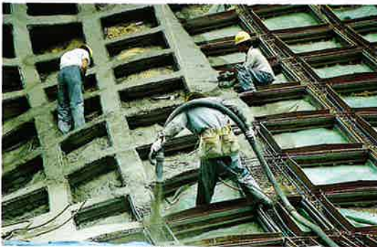
▲法枠モルタル吹付
