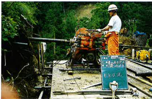
▲集水ボーリング削孔
