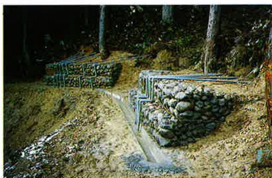
▲地下水低下を目的とする横ボーリング
