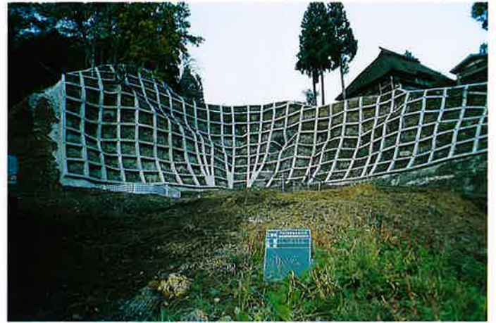
▲完成した法砕工
