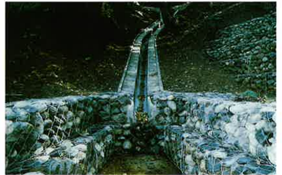
▲明暗渠工完成
