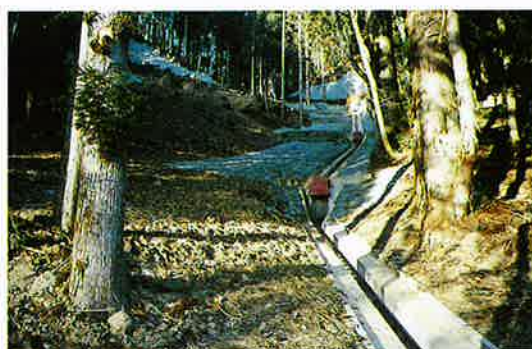
▲水路整備状況
