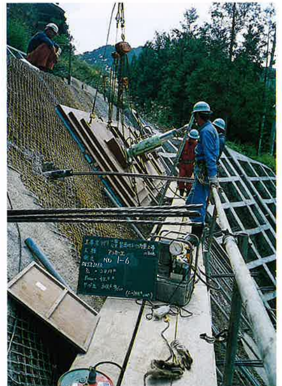
▲アンカー確認試験中
