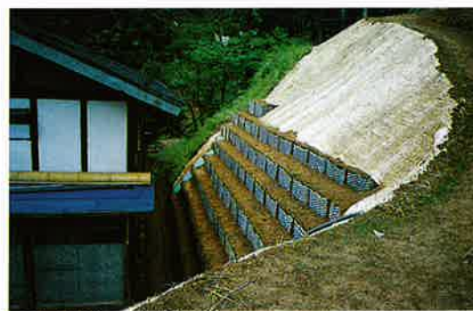
▲民家裏 崩壊対策
