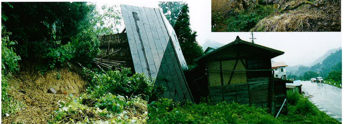
▲末端押し出しにより土蔵の倒壊
