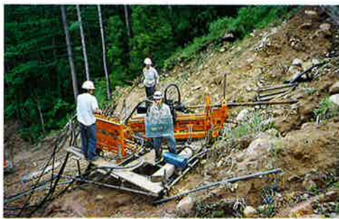
▲集水ボーリング削孔中
