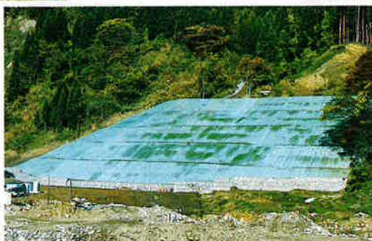
◀ 37,500m³の押え盛土法面工完了
