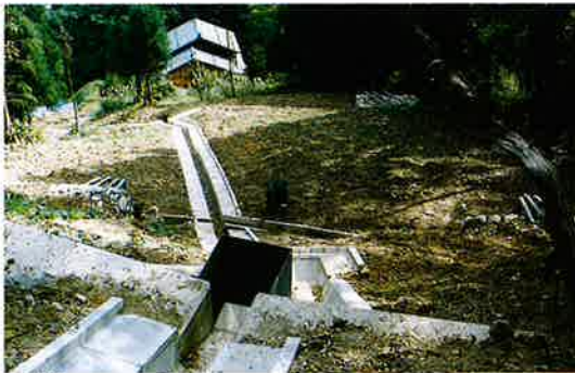
▲排水路工完成
