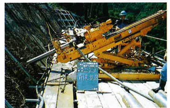
▲アンカー削孔状況
