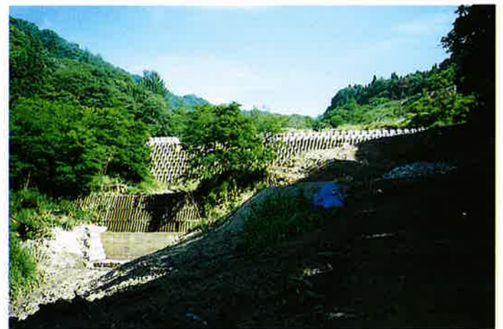
▲嵩上げの終わったコンクリートブロックダム
