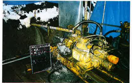
▲横ボーリング削孔
