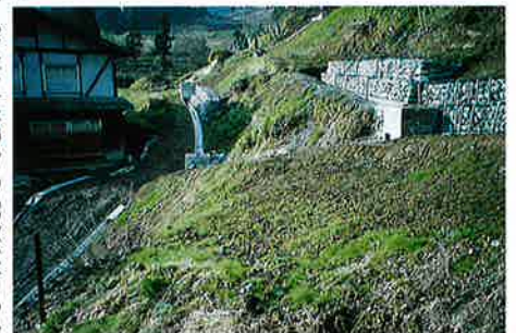
▲水路工及び横ボーリング工完成
