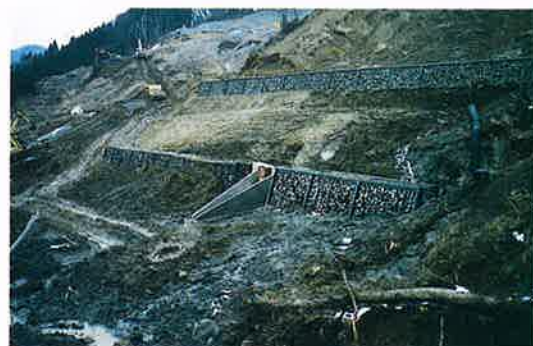
▲土砂の崩壊を防ぐため設置した 鋼製自在枠土留工
